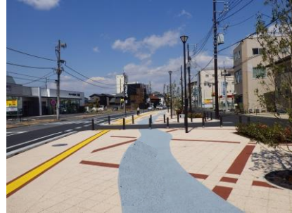
回遊性を生み出す開放的な歩行者空間
