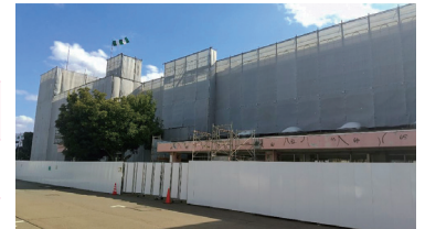
令和5年度の都和南小学校長寿命化改良工事
