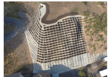
急傾斜地崩壊対策工事
