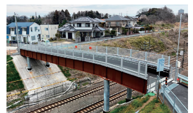
小松ヶ丘町と富士崎二丁目 架かる工事完了後の二番橋
