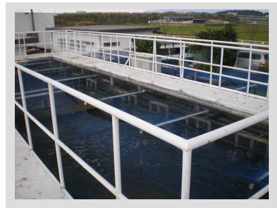
【虫掛生活排水路浄化施設(撤去済)】
