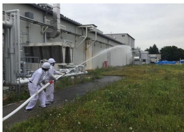
屋外消火栓放水訓練
