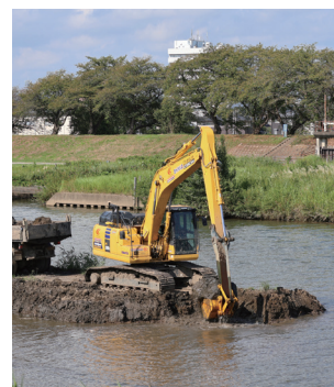
▲桜川の汚泥の浚渫
