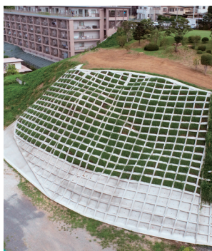
▲急傾斜地崩壊対策工事
