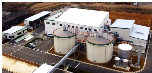
メタン発酵・堆肥化施設 日立セメント(株)
