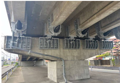
東真鍋1号橋（木田余立体橋） （耐震・長寿命化工事）
