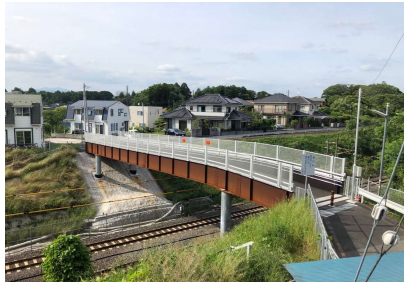
常磐線3号橋（二番橋） （橋梁架替工事）
