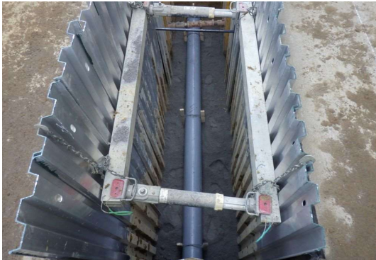
汚水管渠布設工事
