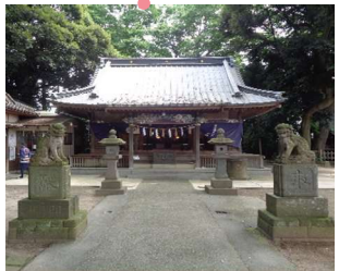
建造物：八坂神社拝殿
