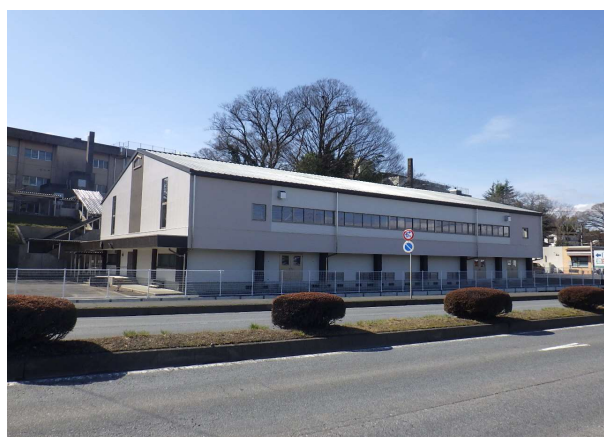
東小学校屋内運動場長寿命化改良工事（外観）
