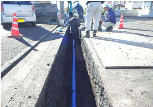
港町一丁目地内配水管布設工事
