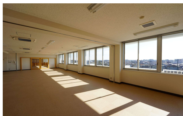
土浦第四中学校校舎棟長寿命化改良工事（内装）
