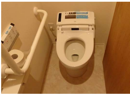
穴塚町公民館修繕 (トイレ個室整備・手摺りの設置等)
