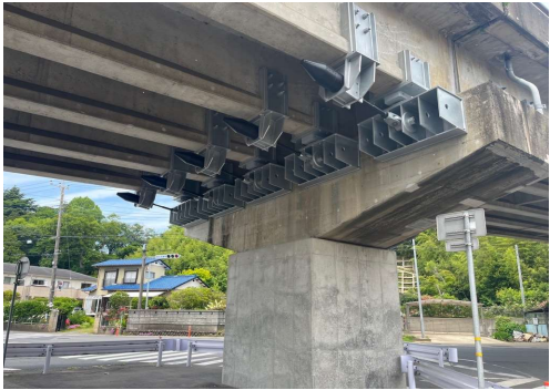
東真鍋1号橋（木田余立体橋） 落橋防止施工後
