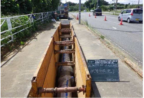
右艸地内送水管布設替工事
