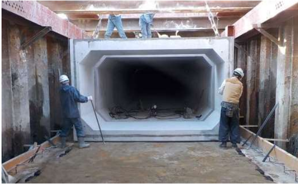
木田余1号雨水幹線整備状況
