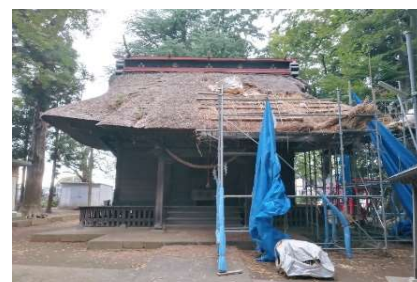
愛宕神社本拝殿茅屋根の 修理の様子
