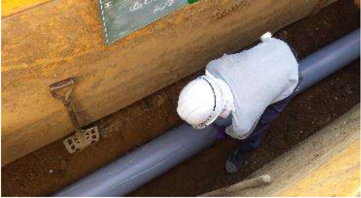
右籾地内 汚水管渠整備状況
