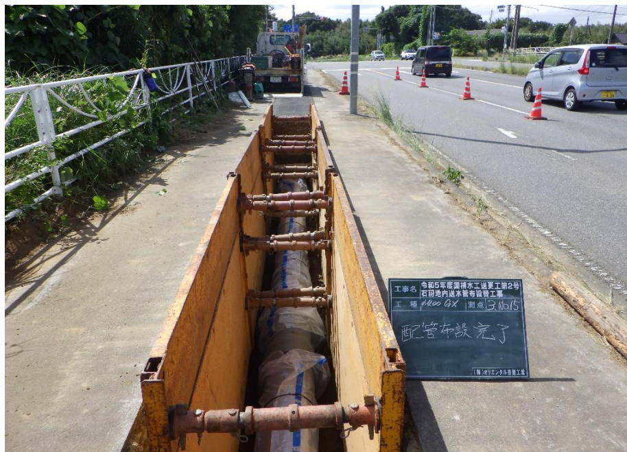
右側地内送水管布設替工事の様子
