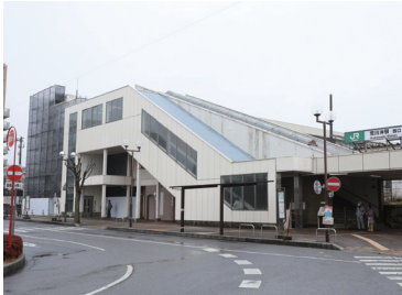
荒川沖駅自由通路の改修工事
