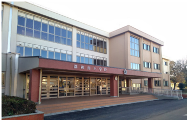
令和6年度都和南小学校 長寿命化改良工事完成
