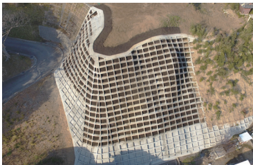
急傾斜地崩壊対策工事
