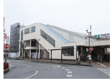
荒川沖駅自由通路の改修工事
