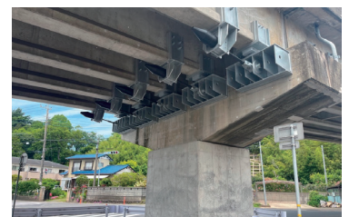
東真鍋1号橋(木田余立体橋) 落橋防止施工後
