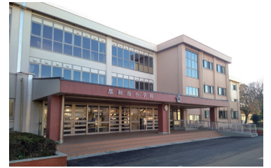
令和6年度都和南小学校長寿命化改良工事完成
