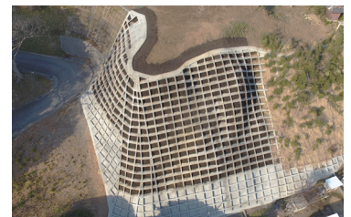
急傾斜地崩壊対策工事
