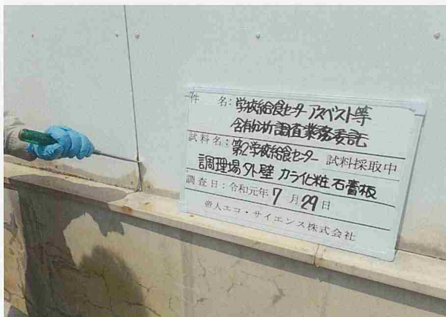
第2学校給食センター 調理場 外壁 カラー化粧石膏板 試料採取中 令和元年7月29日
