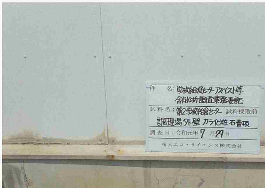
第2学校給食センター 調理場 外壁 カラー化粧石膏板 試料採取前 令和元年7月29日
