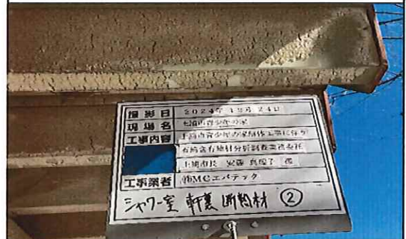
シャワー室 1階 軒裏 断熱材② 補修後
