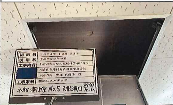
本館 宿泊室No.5 2階 天井裏点検口 スタイロフォーム① 採取後
