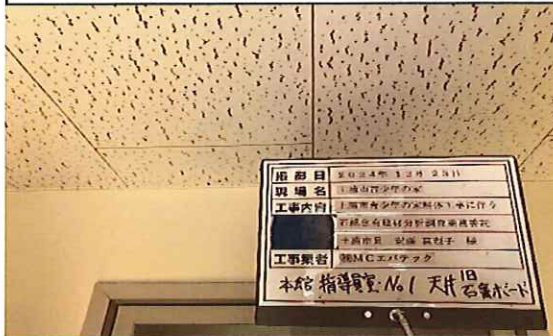
本館 指導員室No.1 1階 天井 旧;石膏ボード(ジブトーン)② 採取前
