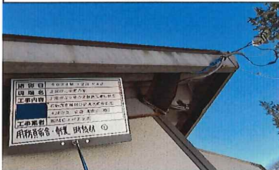
用務員宿舎 1階 軒裏 断熱材① 採取前
