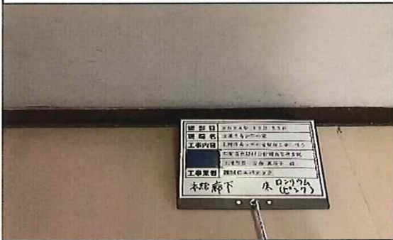
本館 廊下 1階 床 ロンリウム(色;ピンク)② 採取前
