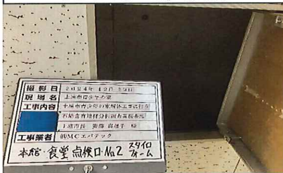
本館 食堂 1階 天井裏点検口No.2 スタイロフォーム③ 採取前
