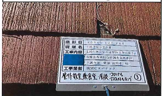
屋外教室兼食堂 1階 屋根 アスファルトルーフィング③ 補修後
