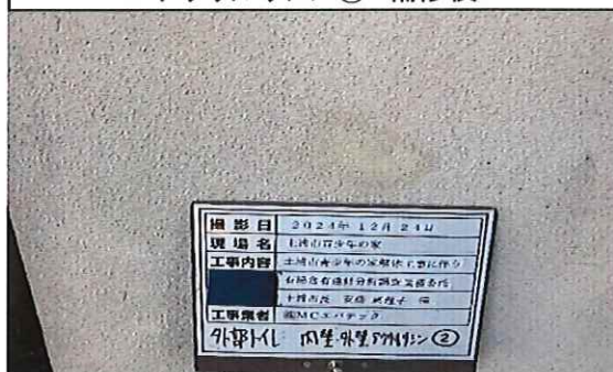
外部トイレ(竣工年1986年) 1階 外壁 アクリルリシン② 補修後
