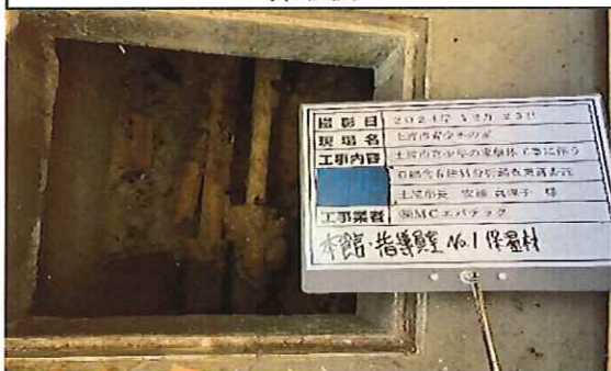
本館 指導員室No.1 1階 床下配管 保温材 採取後
