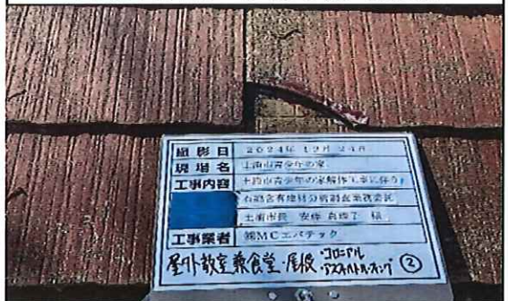
屋外教室兼食堂 1階 屋根 アスファルトルーフィング② 補修後
