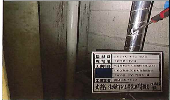
本館 洗面所入口 1階 点検口内部配管(銀) 保温材 採取中
