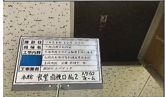
本館 食堂 1階 天井裏点検口No.2 スタイロフォーム③ 補修後
