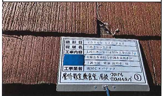
屋外教室兼食堂 1階 屋根 コロニアル③ 補修後
