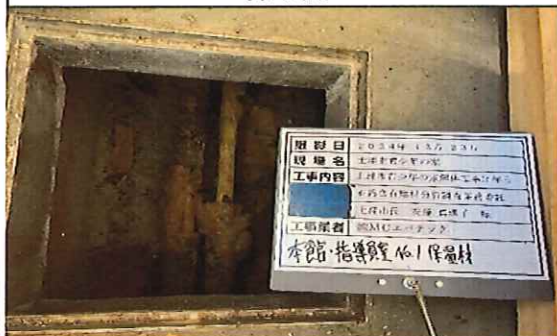
本館 指導員室No.1 1階 床下配管 保温材 採取前
