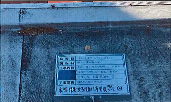
本館外部(増築;女子洗面所等) 1階 屋根 防水シート② 採取後
