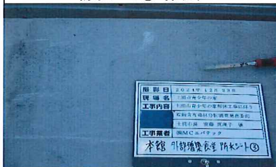
本館外部(増築;食堂) 1階 屋根 防水シート③ 採取中
