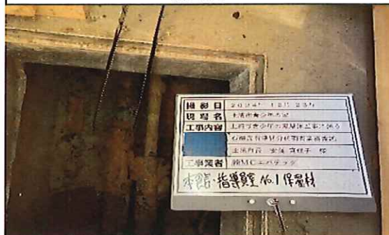
本館 指導員室No.1 1階 床下配管 保温材 採取中
