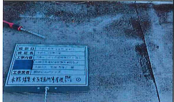
本館外部(増築;女子洗面所等) 1階 屋根 防水シート① 採取中
