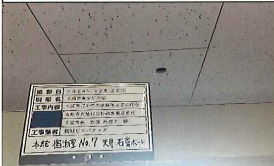
本館 宿泊室No.7 2階 天井 新;石膏ボード② 採取後
