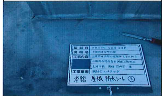
本館外部 1階 屋根 防水シート③ 採取中
