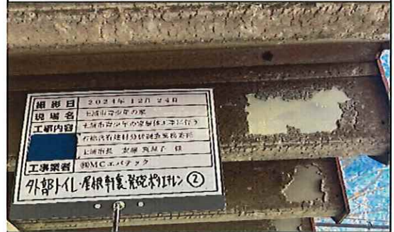
外部トイレ(竣工年1986年) 1階 屋根 軒裏 発泡ポリエチレン② 補修後
