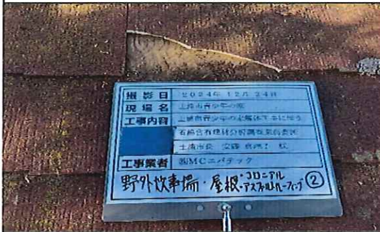
野外炊事場 1階 屋根 コロニアル② 採取後
