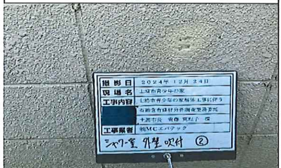
シャワー室 外壁 吹付② 補修後
