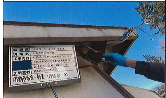
用務員宿舎 1階 軒裏 断熱材① 採取中
