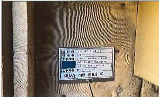
機械室 1階 内部 保温材① 採取前
