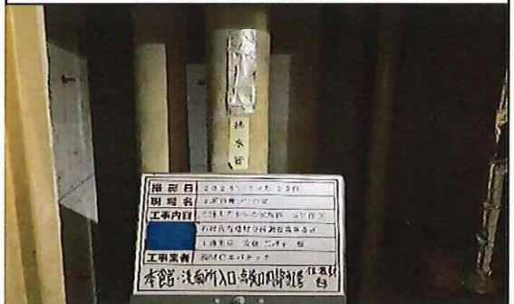
本館 洗面所入口 1階 点検口内部配管(白) 保温材 補修後
