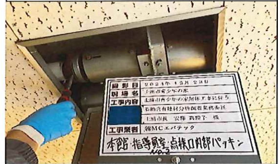
本館 指導員室No.2 1階 点検口内部 パッキン 採取中
