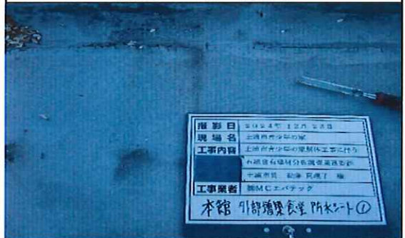
本館外部(増築;食堂) 1階 屋根 防水シート① 採取中
