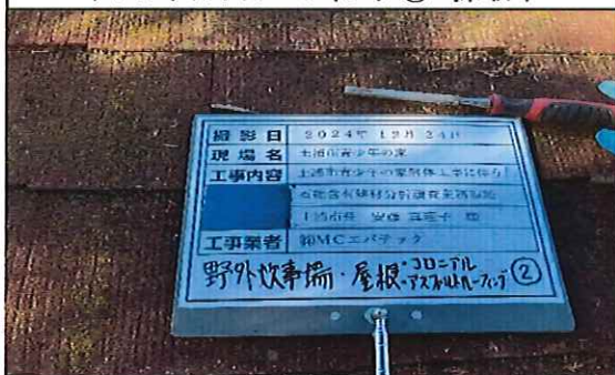
野外炊事場 1階 屋根 アスファルトルーフィング② 採取中
