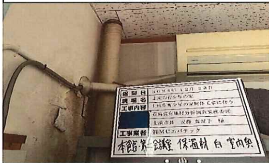
本館 第二会議室 1階 室内奥 配管(白) 保温材 採取中
