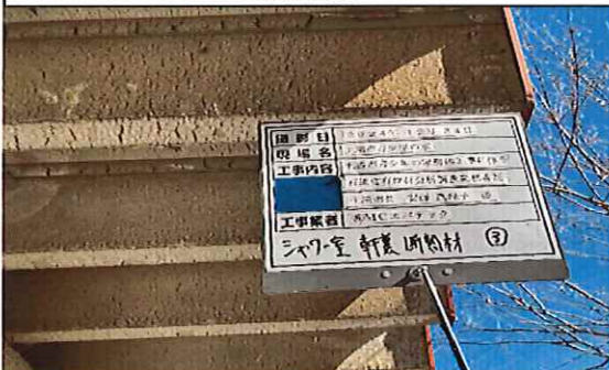
シャワー室 1階 軒裏 断熱材③ 採取前
