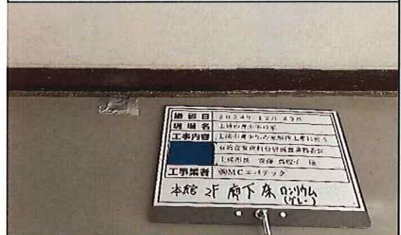
本館 廊下 2階 床 ロンリウム(色;グレー)② 補修後
