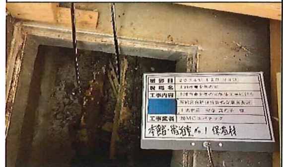
本館 宿泊室No.1 1階 床下配管 保温材 採取中
