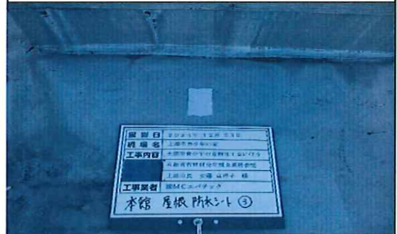
本館外部 1階 屋根 防水シート③ 補修後
