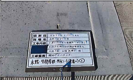
本館外部 2階 屋根 防水シート(色違い箇所)① 採取後
