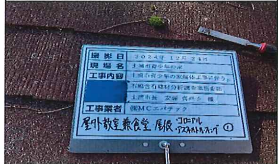
屋外教室兼食堂 1階 屋根 アスファルトルーフィング① 採取中
