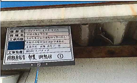
用務員宿舎 1階 軒裏 断熱材② 採取後
