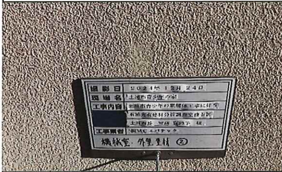
機械室 1階 外壁 塗材② 採取後
