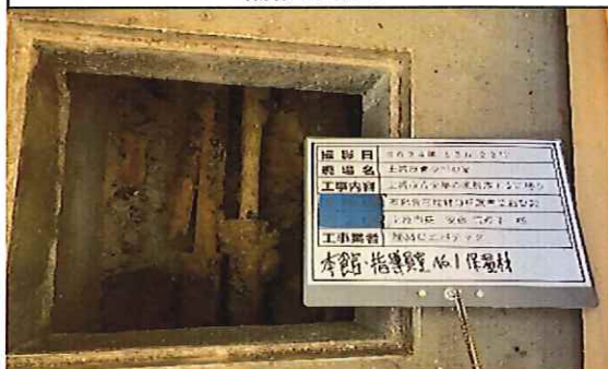
本館 指導員室No.1 1階 床下配管 保温材 補修は無し
