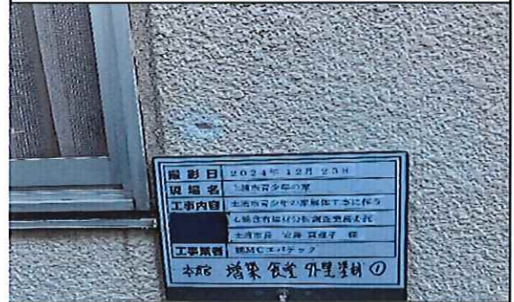
本館外部(増築;食堂) 1階 外壁 塗材① 補修後
