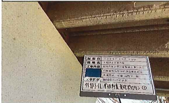
外部トイレ(竣工年1986年) 1階 屋根 軒裏 発泡ポリエチレン① 採取前
