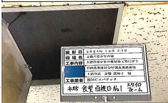
本館 食堂 1階 天井裏点検口No.1 スタイロフォーム② 採取後
