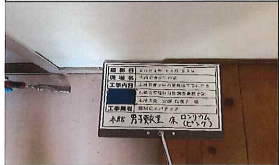
本館 男子脱衣室 1階 床 ロンリウム(色;ピンク)③ 採取中
