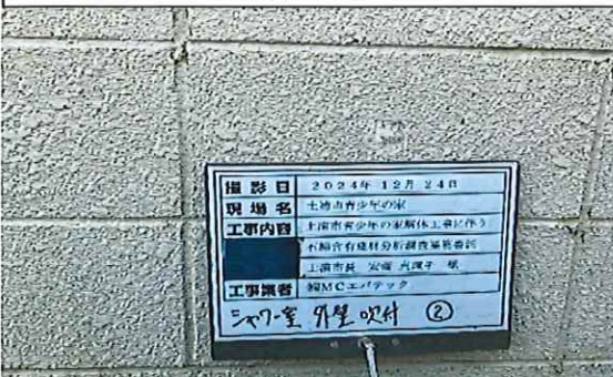
シャワー室 外壁 吹付② 採取後
