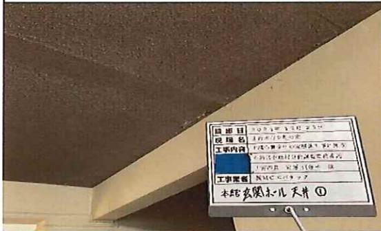
本館 玄関ホール 1階 天井 蛭石吹付① 採取前
