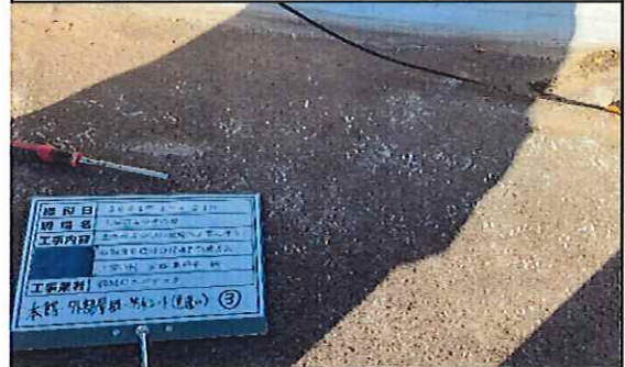
本館外部 2階 屋根 防水シート(色違い箇所)③ 採取中
