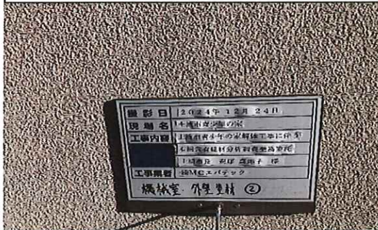
機械室 1階 外壁 塗材② 採取前
