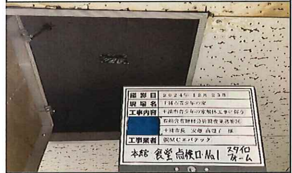
本館 食堂 1階 天井裏点検口No.1 スタイロフォーム② 補修後
