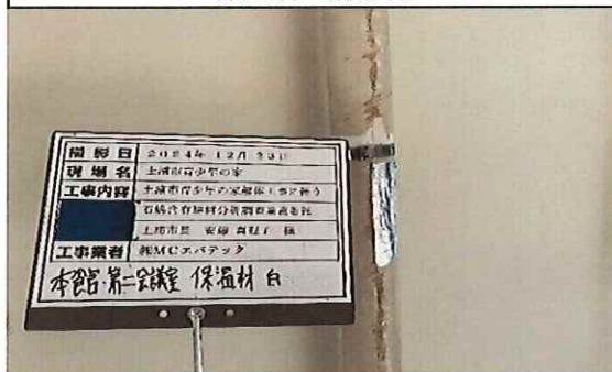
本館 第二会議室 1階 配管(白) 保温材 補修後
