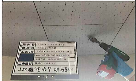
本館 宿泊室No.7 2階 天井 新;石膏ボード② 採取中
