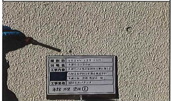
本館外部 1階 外壁 塗材② 採取中
