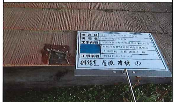
研修室外部 1階 屋根 コロニアル葺き① 補修後
