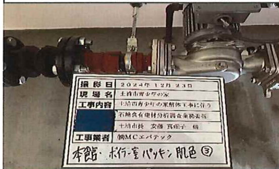
本館 ボイラー室 1階 配管 パッキン(色;肌色)③ 採取前
