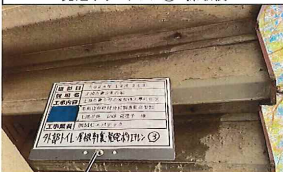
外部トイレ(竣工年1986年) 1階 屋根 軒裏 発泡ポリエチレン③ 採取後
