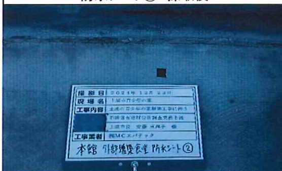
本館外部(増築;食堂) 1階 屋根 防水シート② 採取後
