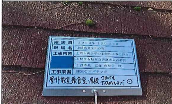
屋外教室兼食堂 1階 屋根 アスファルトルーフィング① 採取前
