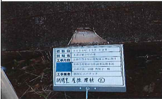
研修室外部 1階 屋根 コロニアル葺き② 採取後
