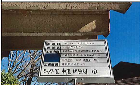
シャワー室 1階 軒裏 断熱材① 補修後
