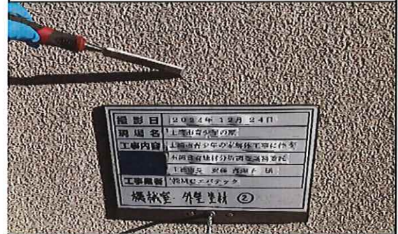
機械室 1階 外壁 塗材② 採取中
