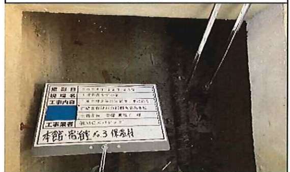
本館 宿泊室No.3 1階 床下配管 保温材 採取中
