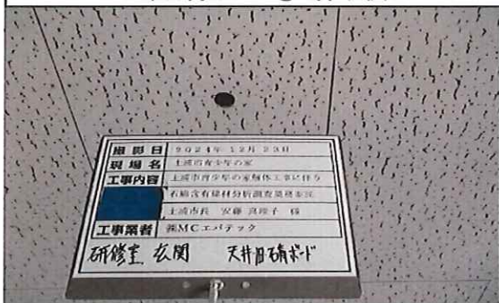
研修室 玄関 1階 天井 旧;石膏ボード① 採取後
