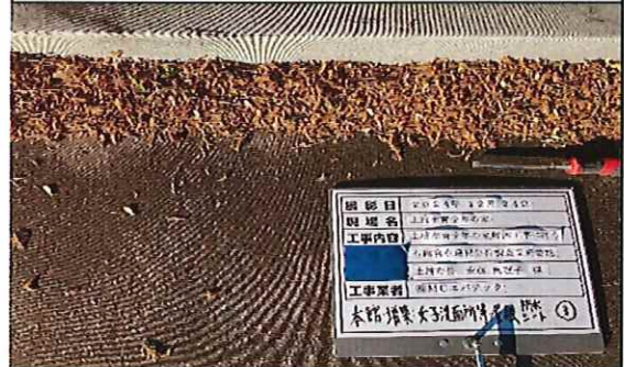
本館外部(増築;女子洗面所等) 1階 屋根 防水シート③ 採取中
