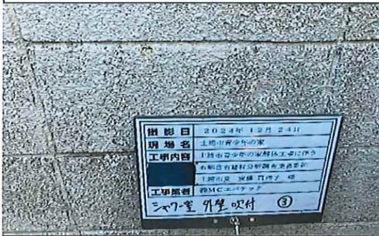
シャワー室 外壁 吹付③ 採取後
