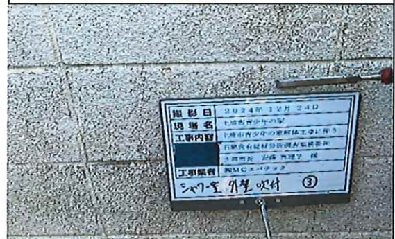
シャワー室 外壁 吹付③ 採取中
