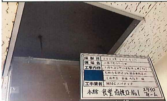
本館 食堂 1階 天井裏点検口No.1 スタイロフォーム② 採取前
