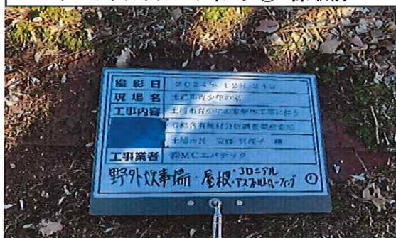
野外炊事場 1階 屋根 アスファルトルーフィング① 採取前
