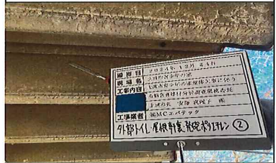
外部トイレ(竣工年1986年) 1階 屋根 軒裏 発泡ポリエチレン② 採取中
