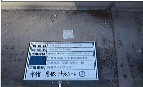
本館外部 1階 屋根 防水シート② 補修後
