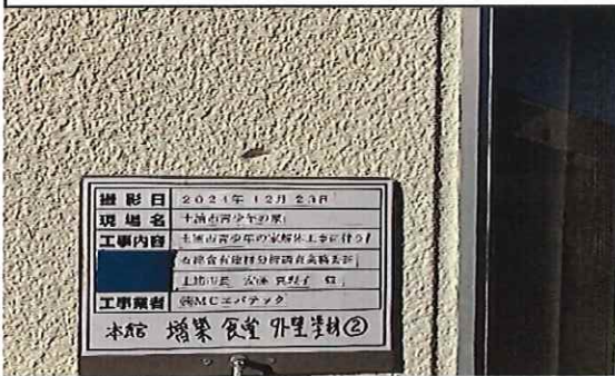
本館外部(増築;食堂) 1階 外壁 塗材② 採取後
