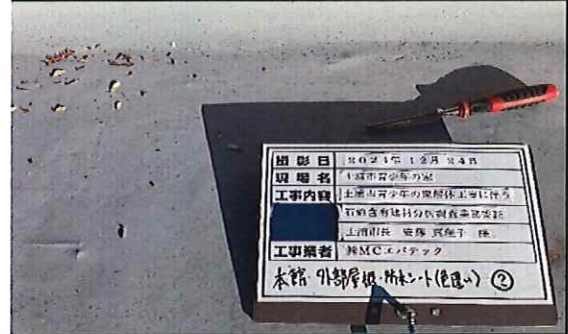
本館外部 2階 屋根 防水シート(色違い箇所)② 採取中
