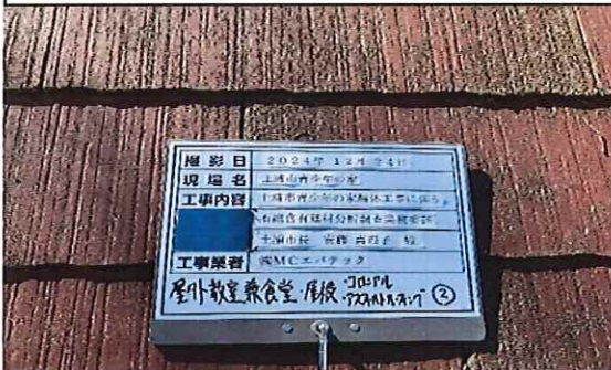
屋外教室兼食堂 1階 屋根 アスファルトルーフィング② 採取前
