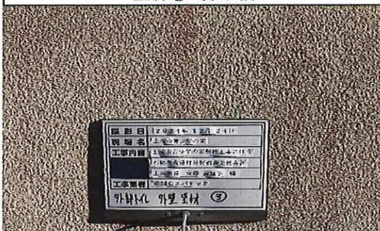
外部トイレ(竣工年1979年) 1階 外壁 塗材③ 採取前
