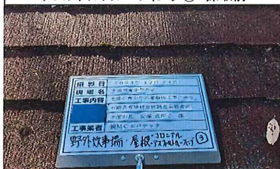
野外炊事場 1階 屋根 アスファルトルーフィング③ 採取前
