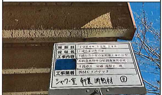
シャワー室 1階 軒裏 断熱材③ 補修後
