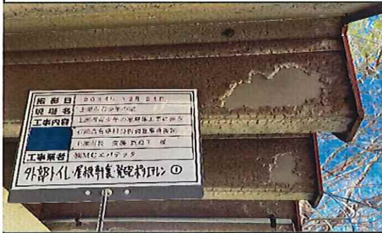
外部トイレ(竣工年1986年) 1階 屋根 軒裏 発泡ポリエチレン① 採取後
