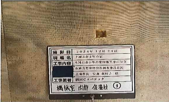
機械室 1階 内部 保温材③ 採取後
