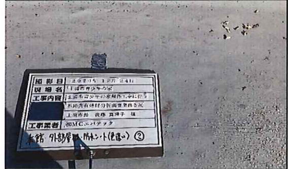
本館外部 2階 屋根 防水シート(色違い箇所)② 補修後
