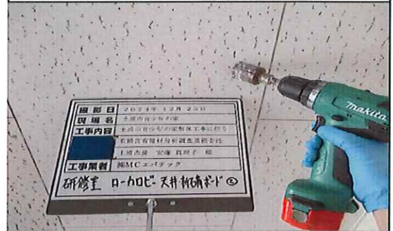
研修室 ローカ・ロビー 1階 天井 新;石膏ボード② 採取中
