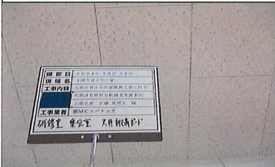
研修室 集会室 1階 天井 新;石膏ボード③ 採取前
