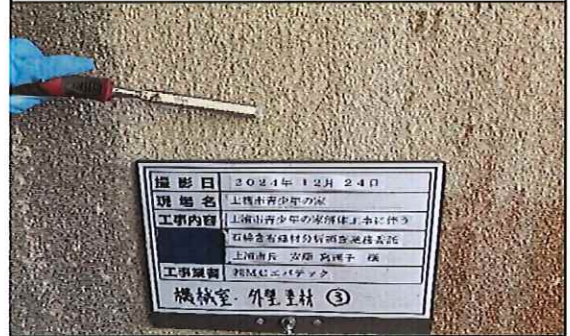
機械室 1階 外壁 塗材③ 採取中
