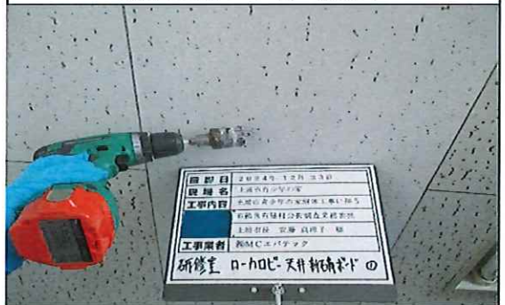
研修室 ローカ・ロビー 1階 天井 新;石膏ボード① 採取中
