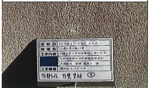
外部トイレ(竣工年1979年) 1階 外壁 塗材③ 補修後
