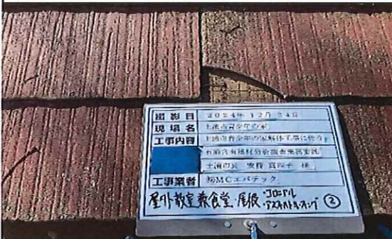
屋外教室兼食堂 1階 屋根 コロニアル② 採取後
