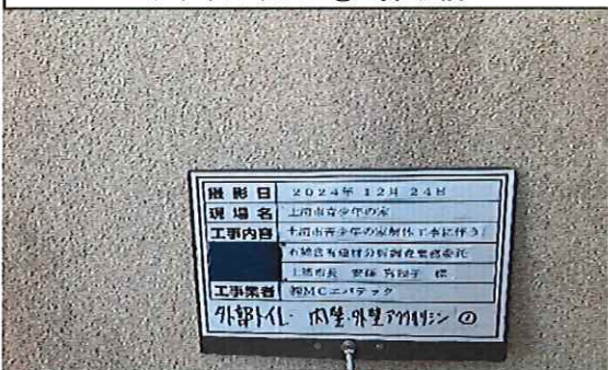
外部トイレ(竣工年1986年) 1階 外壁 アクリルリシン① 採取前
