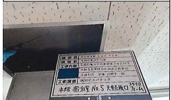
本館 宿泊室No.5 2階 天井裏点検口 スタイロフォーム① 採取中
