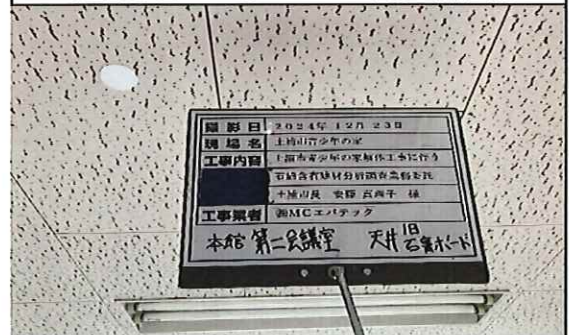
本館 第二会議室 1階 天井 旧;石膏ボード(ジブトーン)③ 補修後
