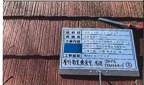
屋外教室兼食堂 1階 屋根 コロニアル② 採取中
