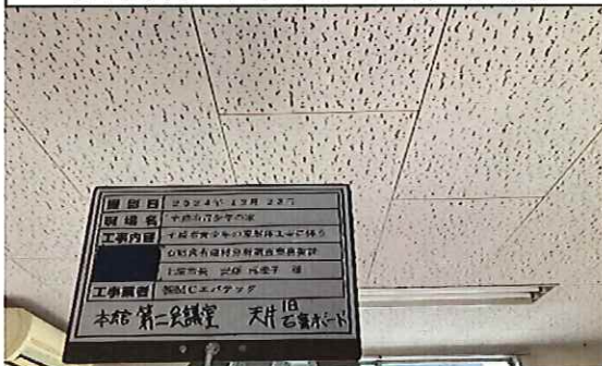
本館 第二会議室 1階 天井 旧;石膏ボード(ジブトーン)③ 採取前
