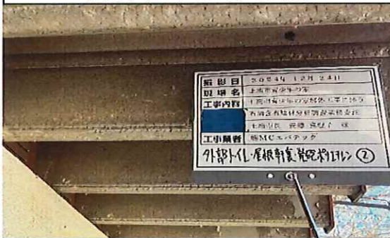
外部トイレ(竣工年1986年) 1階 屋根 軒裏 発泡ポリエチレン② 採取前
