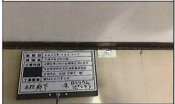
本館 廊下 1階 床 ロンリウム(色;ピンク)② 補修後
