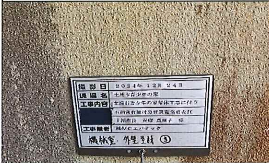
機械室 1階 外壁 塗材③ 採取前
