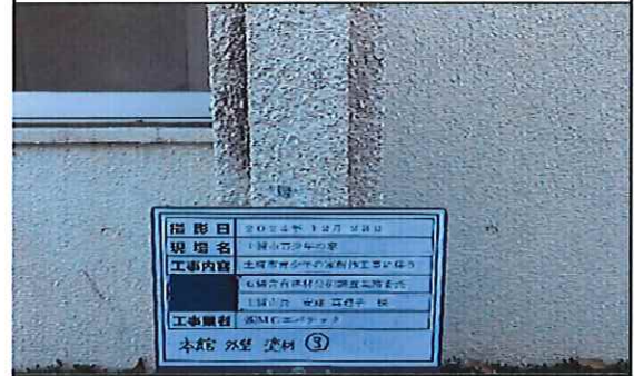
本館外部 1階 外壁 塗材③ 補修後
