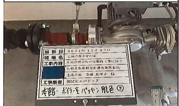
本館 ボイラー室 1階 配管 パッキン(色;肌色)③ 補修後
