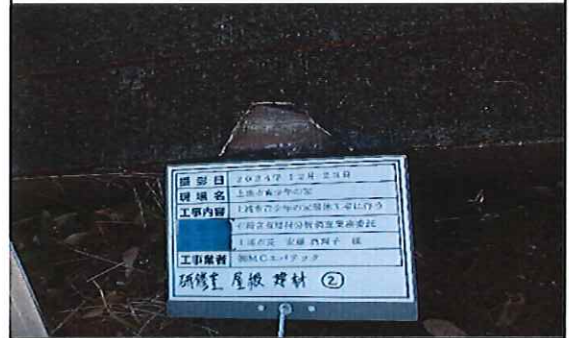
研修室外部 1階 屋根 コロニアル葺き② 補修後
