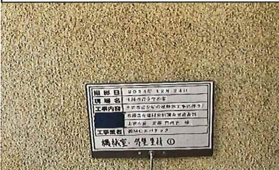
機械室 1階 外壁 塗材① 採取前
