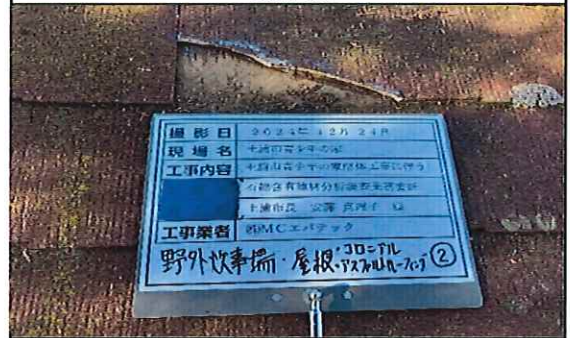
野外炊事場 1階 屋根 コロニアル② 補修後
