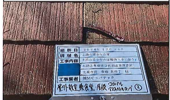
屋外教室兼食堂 1階 屋根 コロニアル② 補修後
