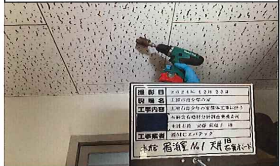
本館 宿泊室No.1 1階 天井 旧;石膏ボード(ジプトーン)① 採取中
