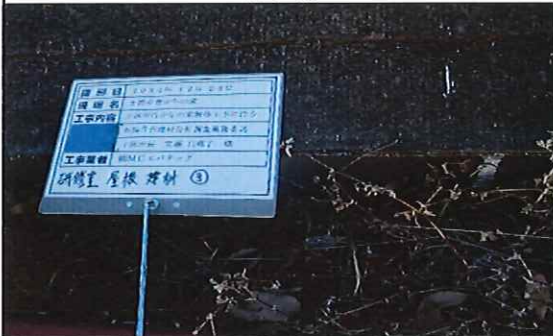
研修室外部 1階 屋根 コロニアル葺き③ 採取前
