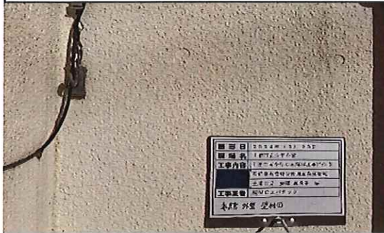
本館外部 1階 外壁 塗材① 採取前
