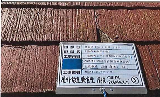
屋外教室兼食堂 1階 屋根 アスファルトルーフィング③ 採取後
