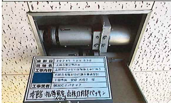
本館 指導員室No.2 1階 点検口内部 パッキン 採取前
