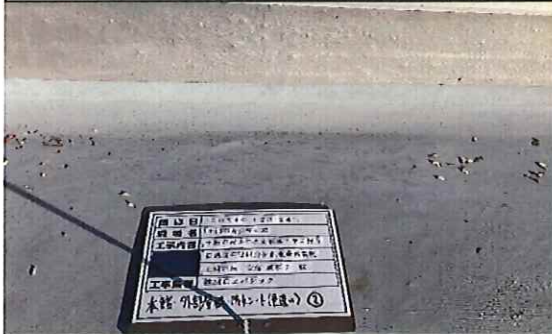
本館外部 2階 屋根 防水シート(色違い箇所)② 採取前
