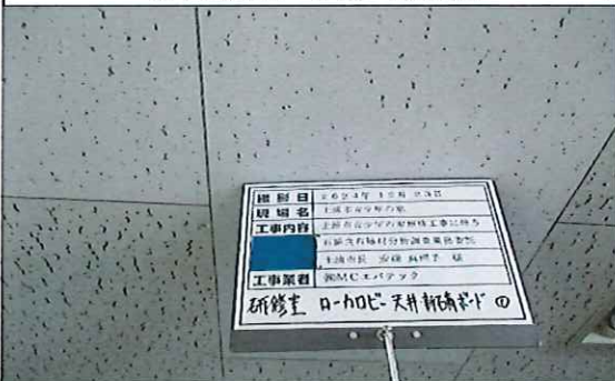
研修室 ローカ・ロビー 1階 天井 新;石膏ボード① 採取前
