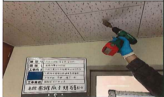
本館 宿泊室No.5 2階 天井 新;石膏ボード① 採取中
