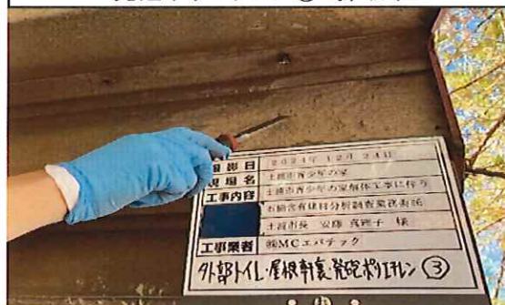
外部トイレ(竣工年1986年) 1階 屋根 軒裏 発泡ポリエチレン③ 採取中
