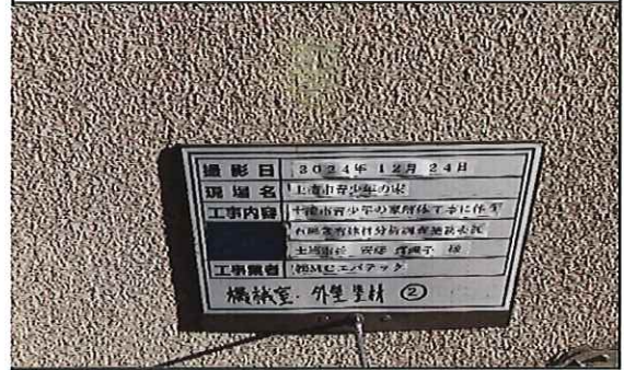
機械室 1階 外壁 塗材② 補修後
