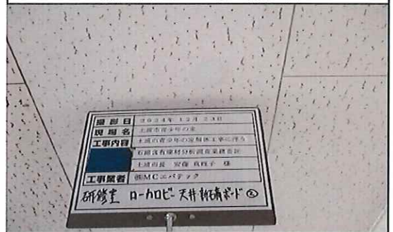
研修室 ローカ・ロビー 1階 天井 新;石膏ボード② 補修後
