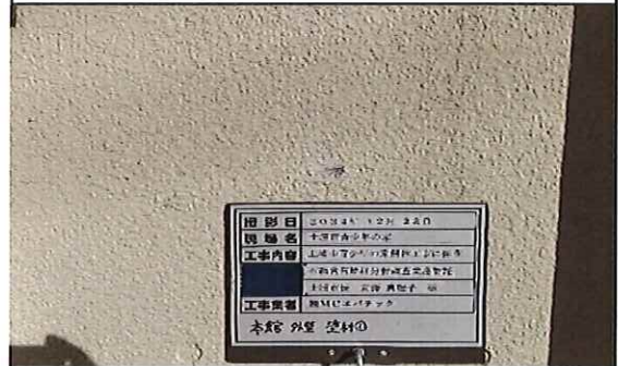
本館外部 1階 外壁 塗材① 補修後
