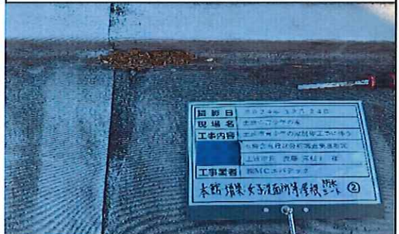
本館外部(増築;女子洗面所等) 1階 屋根 防水シート② 採取中
