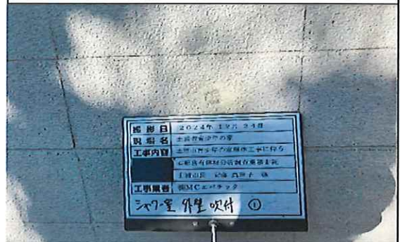
シャワー室 外壁 吹付① 補修後
