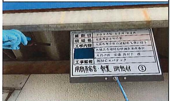
用務員宿舎 1階 軒裏 断熱材② 採取中
