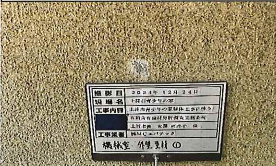
機械室 1階 外壁 塗材① 採取後
