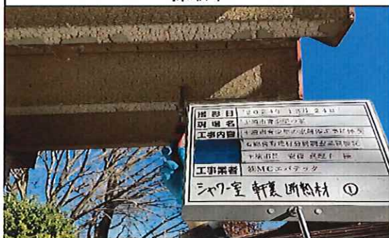
シャワー室 1階 軒裏 断熱材① 採取中
