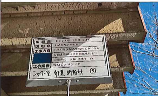
シャワー室 1階 軒裏 断熱材③ 採取後
