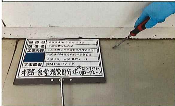
本館 食堂増築部分 1階 床 ロンリウム(色;明るいグレー)③ 採取中
