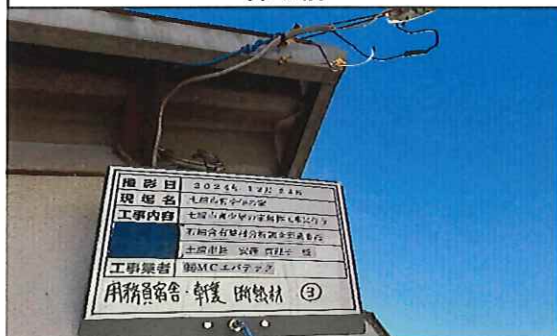
用務員宿舎 1階 軒裏 断熱材③ 採取前
