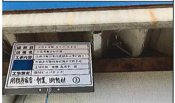
用務員宿舎 1階 軒裏 断熱材② 補修後
