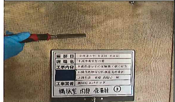
機械室 1階 内部 保温材③ 採取中
