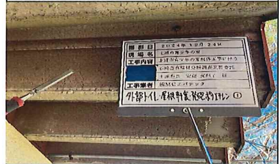
外部トイレ(竣工年1986年) 1階 屋根 軒裏 発泡ポリエチレン① 採取中
