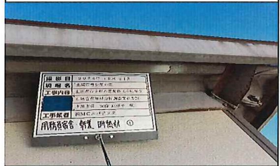
用務員宿舎 1階 軒裏 断熱材① 補修後
