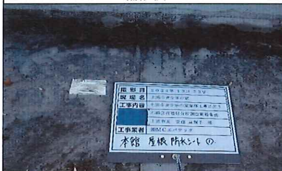
本館外部 1階 屋根 防水シート① 補修後
