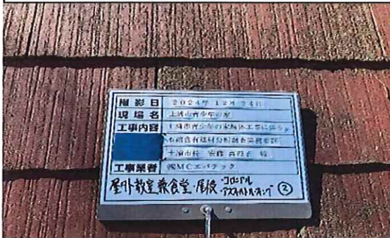
屋外教室兼食堂 1階 屋根 コロニアル② 採取前
