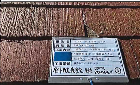
屋外教室兼食堂 1階 屋根 コロニアル③ 採取後
