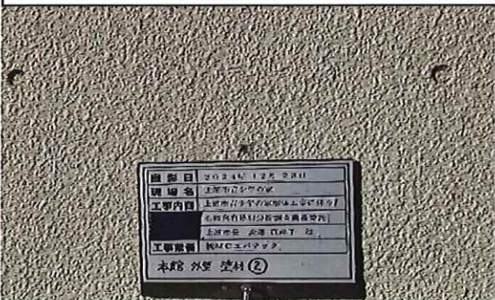
本館外部 1階 外壁 塗材② 採取後
