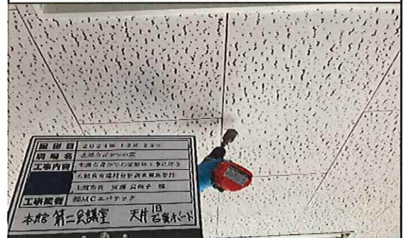
本館 第二会議室 1階 天井 旧;石膏ボード(ジブトーン)③ 採取中
