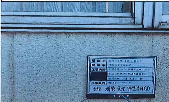
本館外部(増築;食堂) 1階 外壁 塗材③ 採取前
