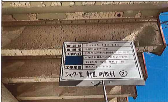
シャワー室 1階 軒裏 断熱材② 採取前
