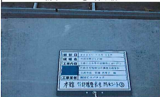
本館外部(増築;食堂) 1階 屋根 防水シート③ 採取前
