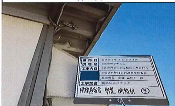
用務員宿舎 1階 軒裏 断熱材③ 採取後
