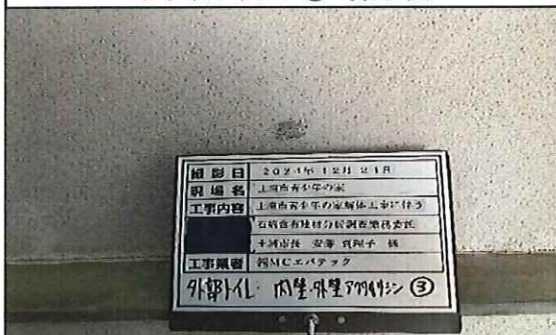
外部トイレ(竣工年1986年) 1階 内壁 アクリルリシン③ 採取後
