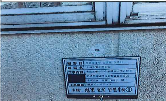
本館外部(増築;食堂) 1階 外壁 塗材③ 採取後
