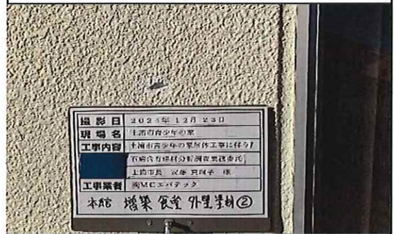
本館外部(増築;食堂) 1階 外壁 塗材② 補修後
