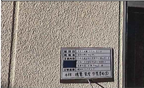
本館外部(増築;食堂) 1階 外壁 塗材② 採取前
