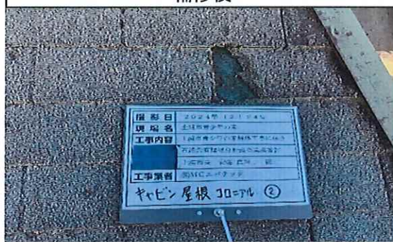
キャビン 1階 屋根 コロニアル② 補修後
