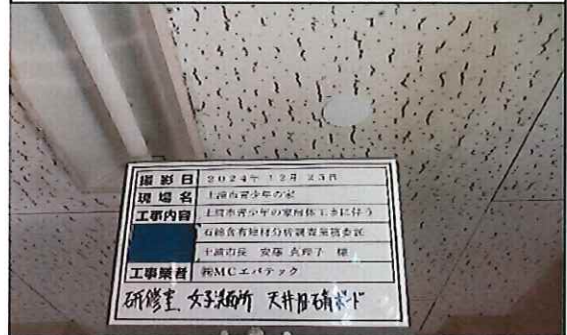
研修室 女子洗面所 1階 天井 旧;石膏ボード③ 補修後
