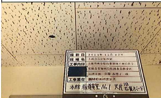
本館 指導員室No.1 1階 天井 旧;石膏ボード(ジブトーン)② 採取後
