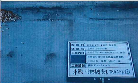
本館外部(増築;食堂) 1階 屋根 防水シート① 採取前
