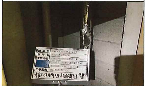
本館 洗面所入口 1階 点検口内部配管(銀) 保温材 補修後
