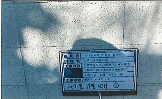
シャワー室 外壁 吹付① 採取前
