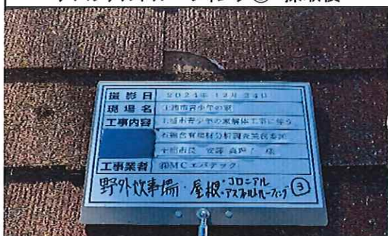
野外炊事場 1階 屋根 アスファルトルーフィング③ 採取後
