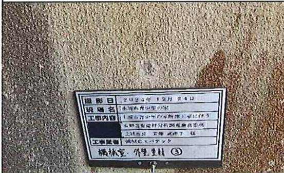
機械室 1階 外壁 塗材③ 採取後
