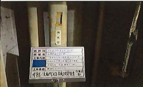
本館 洗面所入口 1階 点検口内部配管(白) 保温材 採取後
