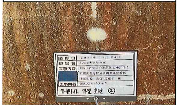
外部トイレ(竣工年1979年) 1階 外壁 塗材② 補修後
