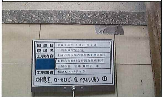
研修室 ローカ・ロビー 1階 床 Pタイル(薄)③ 補修後
