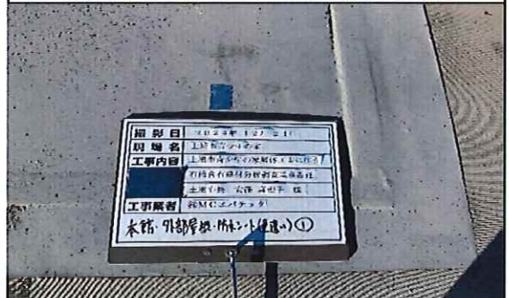
本館外部 2階 屋根 防水シート(色違い箇所)① 補修後
