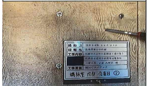
機械室 1階 内部 保温材② 採取中
