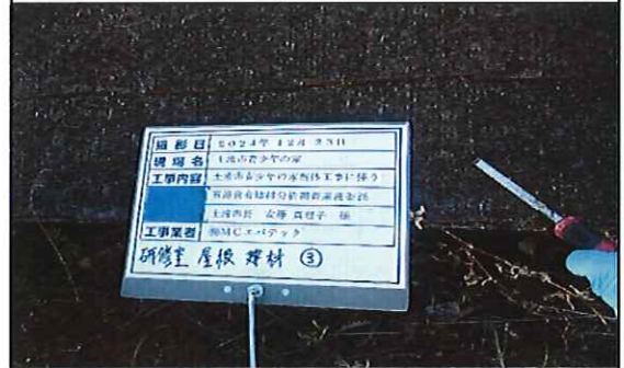
研修室外部 1階 屋根 コロニアル葺き③ 採取中
