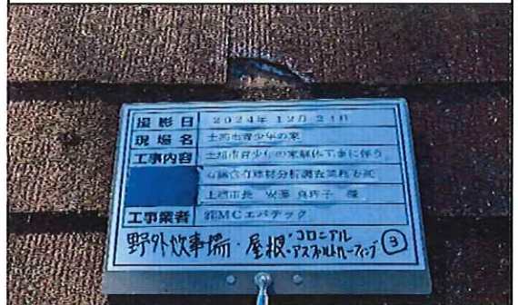
野外炊事場 1階 屋根 コロニアル③ 補修後
