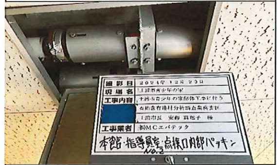
本館 指導員室No.2 1階 点検口内部 パッキン 補修後
