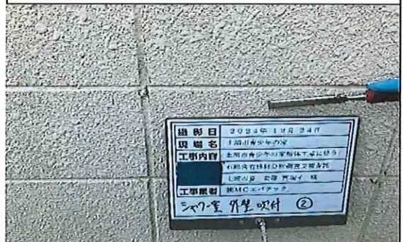
シャワー室 外壁 吹付② 採取中
