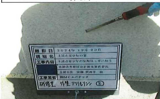
研修室外部 外壁 アクリルリシン② 採取中
