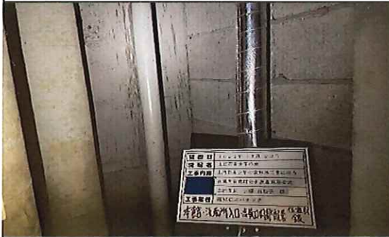
本館 洗面所入口 1階 点検口内部配管(銀) 保温材 採取前
