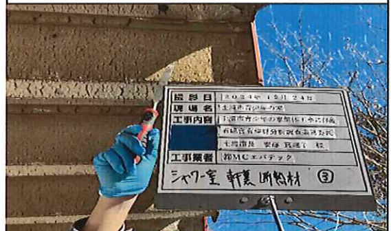
シャワー室 1階 軒裏 断熱材③ 採取中
