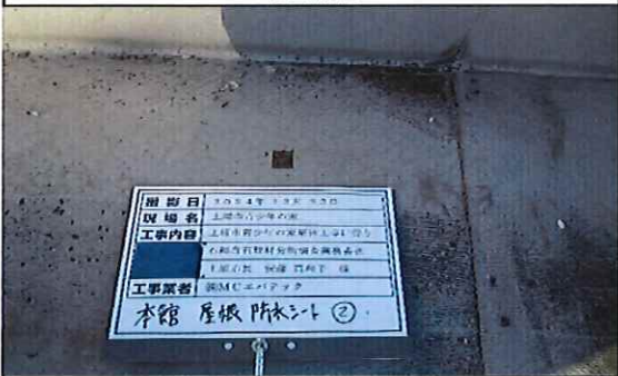
本館外部 1階 屋根 防水シート② 採取後
