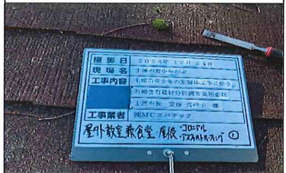
屋外教室兼食堂 1階 屋根 コロニアル① 採取中
