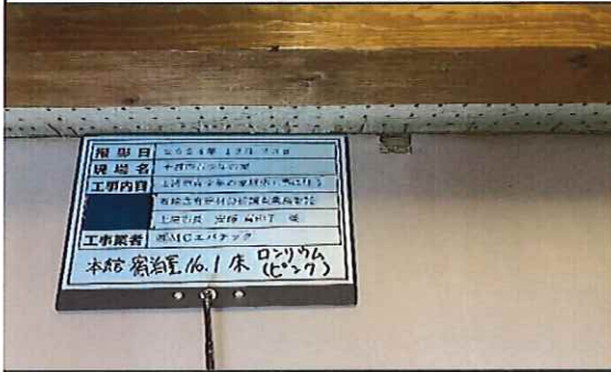
本館 宿泊室No.1 1階 床 ロンリウム(色;ピンク)① 採取後
