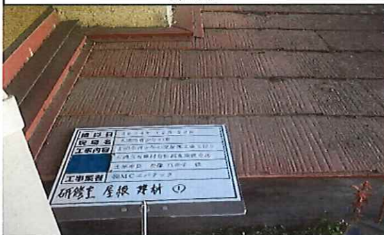
研修室外部 1階 屋根 コロニアル葺き① 採取前
