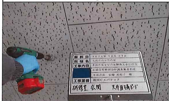
研修室 玄関 1階 天井 旧;石膏ボード① 採取中
