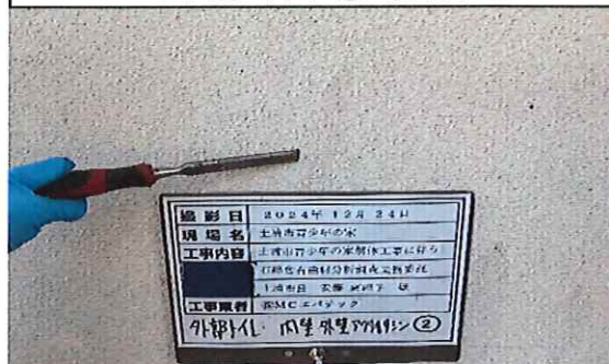
外部トイレ(竣工年1986年) 1階 外壁 アクリルリシン② 採取中
