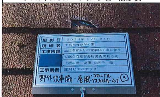
野外炊事場 1階 屋根 アスファルトルーフィング③ 補修後
