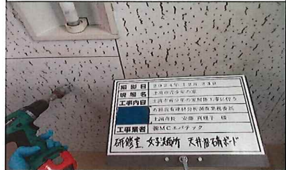
研修室 女子洗面所 1階 天井 旧;石膏ボード③ 採取中
