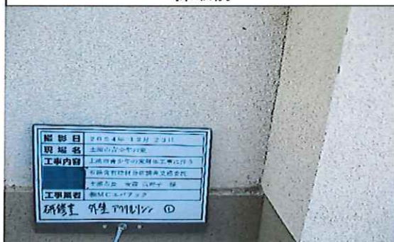
研修室外部 外壁 アクリルリシン① 採取前
