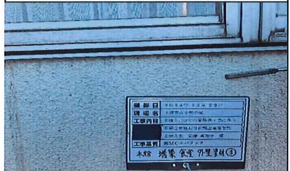
本館外部(増築;食堂) 1階 外壁 塗材③ 採取中
