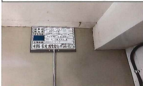
本館 食堂増築部分 1階 床 ロンリウム(色;明るいグレー)② 採取前
