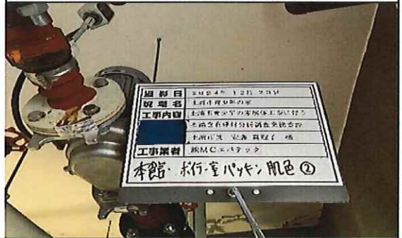
本館 ボイラー室 1階 配管 パッキン(色;肌色)② 補修後
