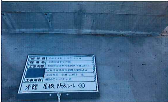
本館外部 1階 屋根 防水シート③ 採取前
