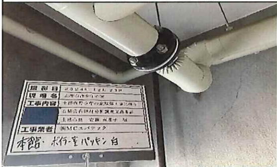
本館 ボイラー室 1階 配管 パッキン(色;白)① 採取前
