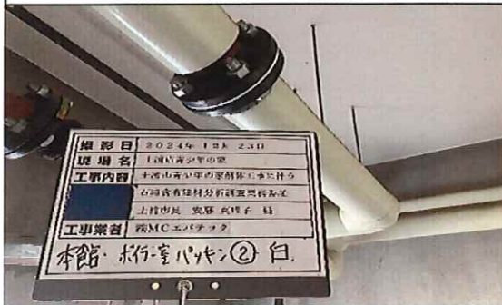
本館 ボイラー室 1階 配管 パッキン(色;白)② 採取前
