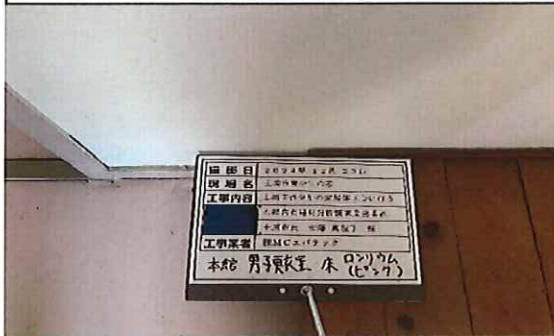
本館 男子脱衣室 1階 床 ロンリウム(色;ピンク)③ 採取前
