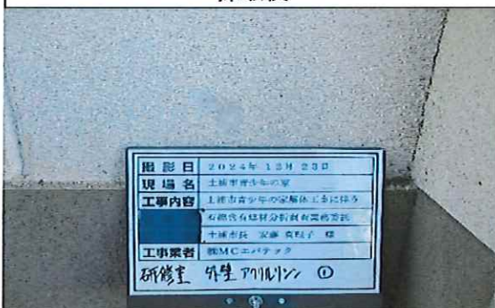
研修室外部 外壁 アクリルリシン① 採取後
