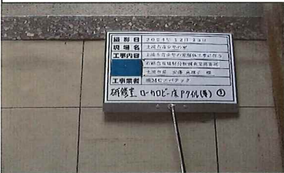
研修室 ローカ・ロビー 1階 床 Pタイル(薄)③ 採取前
