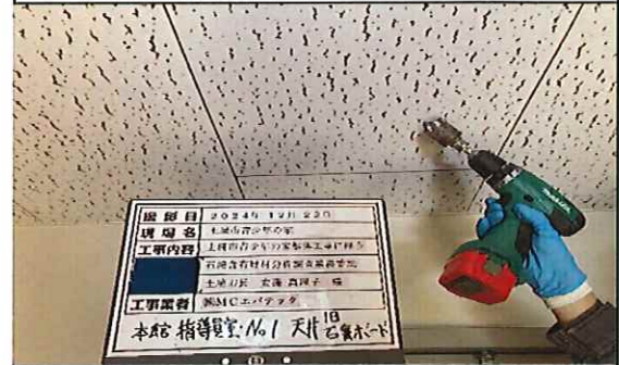
本館 指導員室No.1 1階 天井 旧;石膏ボード(ジブトーン)② 採取中
