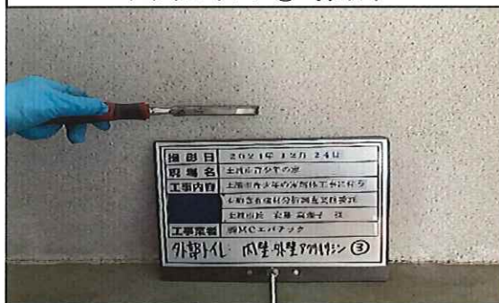
外部トイレ(竣工年1986年) 1階 内壁 アクリルリシン③ 採取中
