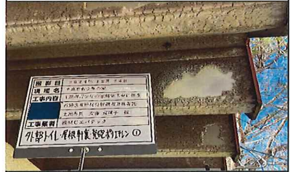
外部トイレ(竣工年1986年) 1階 屋根 軒裏 発泡ポリエチレン① 補修後
