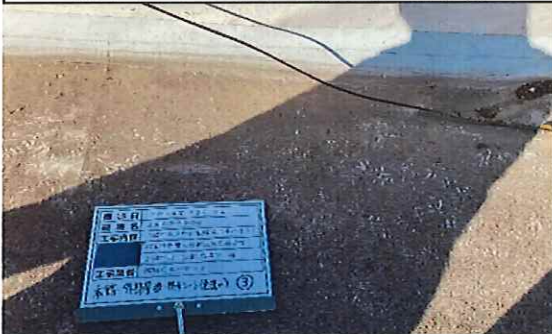
本館外部 2階 屋根 防水シート(色違い箇所)③ 採取前
