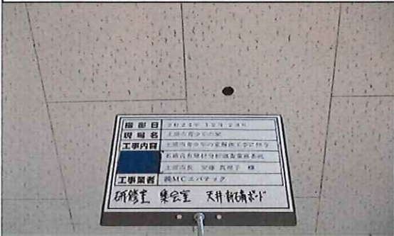
研修室 集会室 1階 天井 新;石膏ボード③ 採取後
