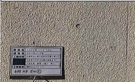
本館外部 1階 外壁 塗材② 採取前
