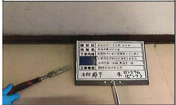
本館 廊下 1階 床 ロンリウム(色;ピンク)② 採取中
