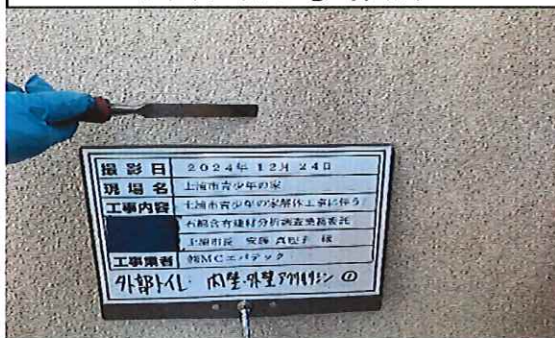
外部トイレ(竣工年1986年) 1階 外壁 アクリルリシン① 採取中
