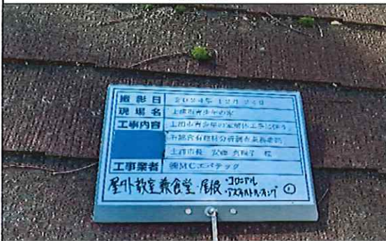
屋外教室兼食堂 1階 屋根 コロニアル① 採取前
