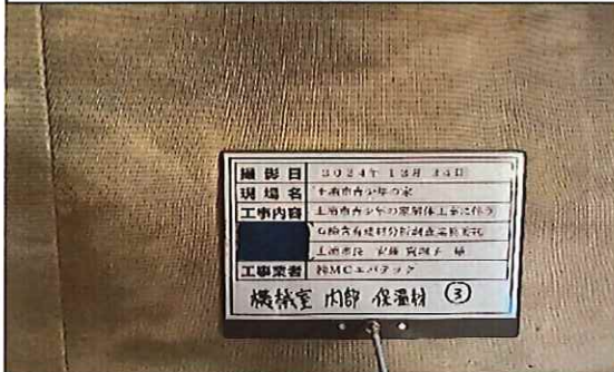
機械室 1階 内部 保温材③ 採取前
