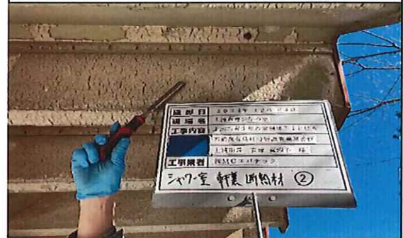
シャワー室 1階 軒裏 断熱材② 採取中
