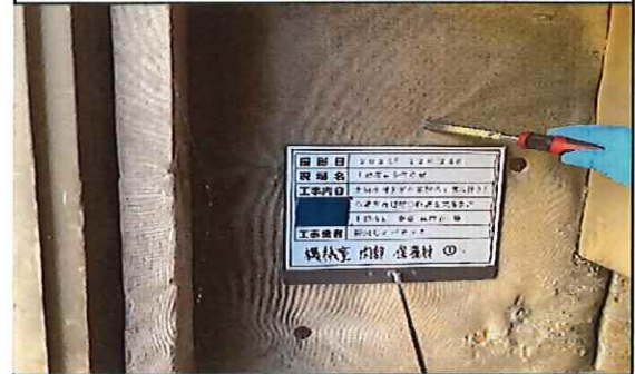
機械室 1階 内部 保温材① 採取中
