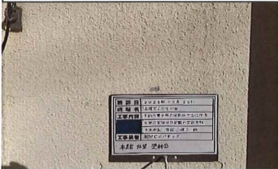
本館外部 1階 外壁 塗材① 採取後
