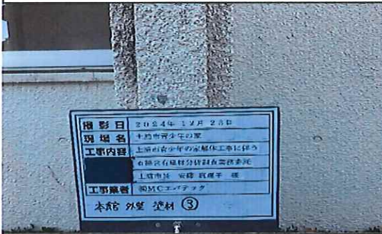
本館外部 1階 外壁 塗材③ 採取後
