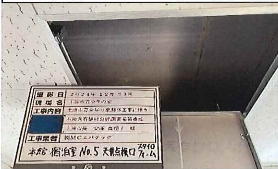
本館 宿泊室No.5 2階 天井裏点検口 スタイロフォーム① 採取前
