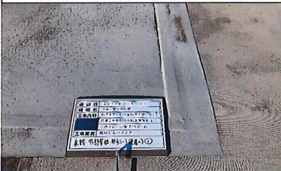
本館外部 2階 屋根 防水シート(色違い箇所)① 採取前
