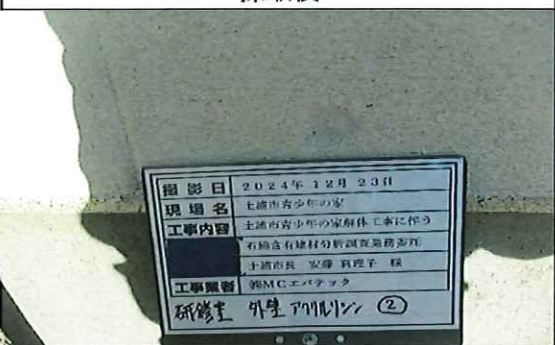
研修室外部 外壁 アクリルリシン② 採取後
