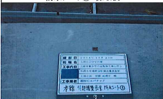
本館外部(増築;食堂) 1階 屋根 防水シート③ 採取後
