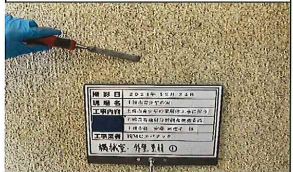
機械室 1階 外壁 塗材① 採取中
