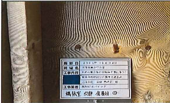
機械室 1階 内部 保温材① 採取後
