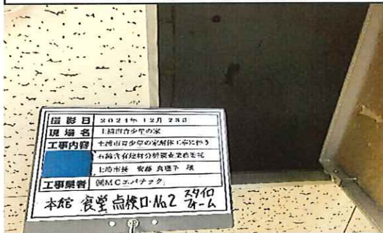
本館 食堂 1階 天井裏点検口No.2 スタイロフォーム③ 採取後
