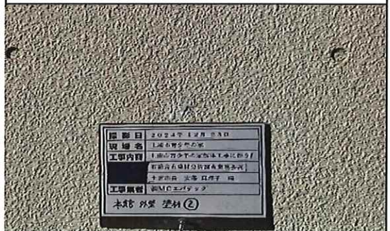
本館外部 1階 外壁 塗材② 補修後
