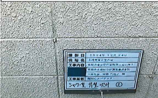
シャワー室 外壁 吹付② 採取前
