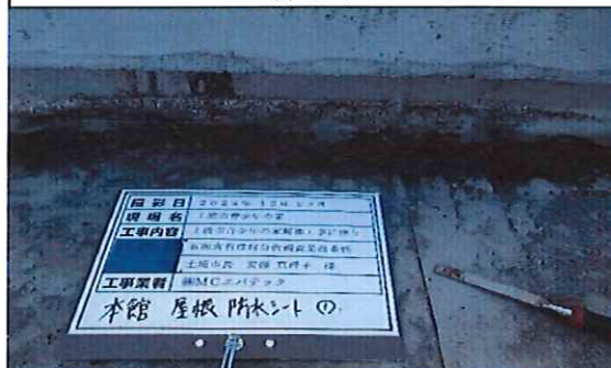
本館外部 1階 屋根 防水シート① 採取中
