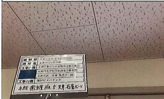
本館 宿泊室No.5 2階 天井 新;石膏ボード① 採取前
