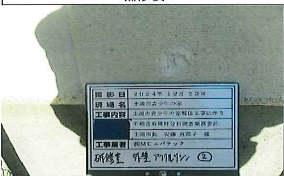
研修室外部 外壁 アクリルリシン② 補修後
