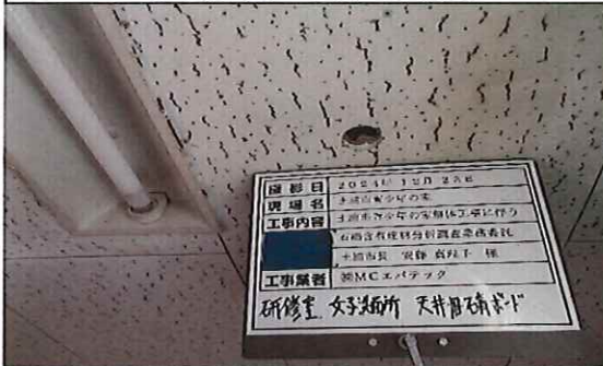
研修室 女子洗面所 1階 天井 旧;石膏ボード③ 採取後
