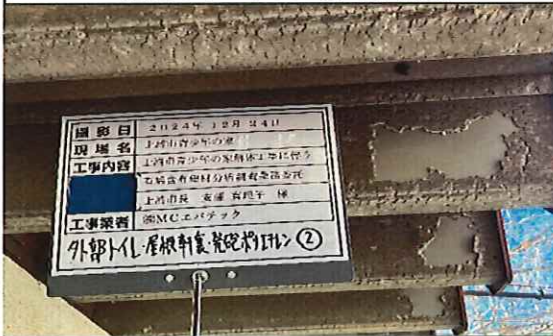
外部トイレ(竣工年1986年) 1階 屋根 軒裏 発泡ポリエチレン② 採取後
