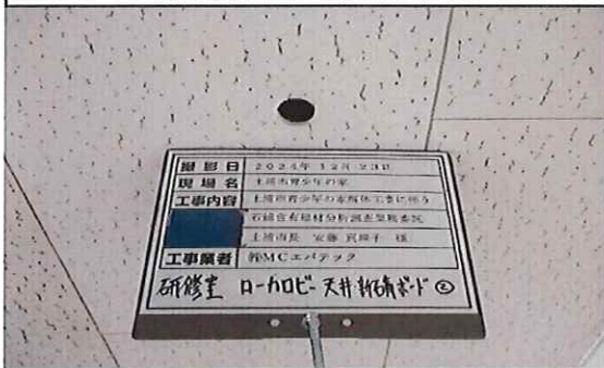
研修室 ローカ・ロビー 1階 天井 新;石膏ボード② 採取後
