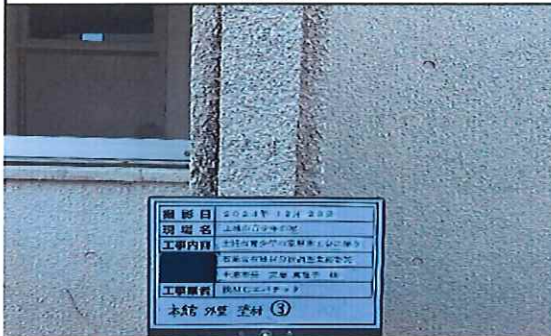
本館外部 1階 外壁 塗材③ 採取前
