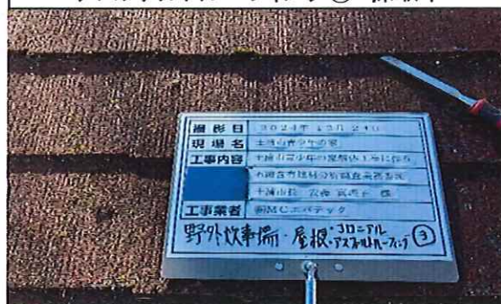
野外炊事場 1階 屋根 アスファルトルーフィング③ 採取中
