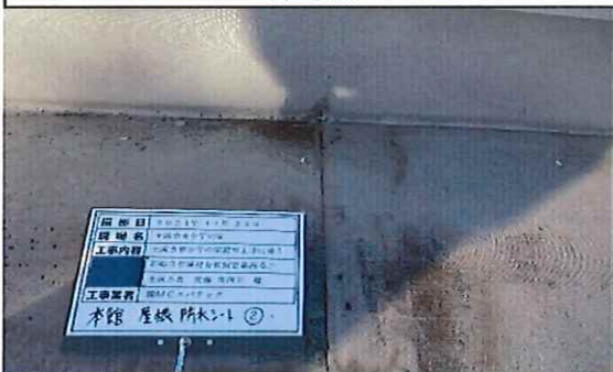
本館外部 1階 屋根 防水シート② 採取前
