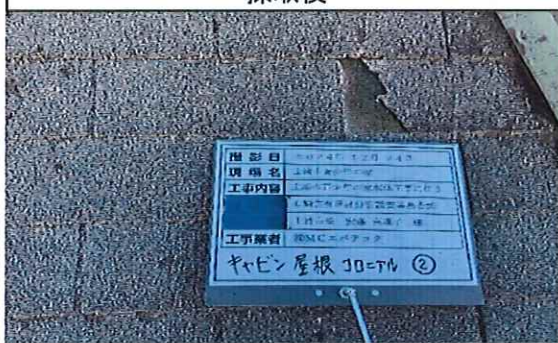
キャビン 1階 屋根 コロニアル② 採取後
