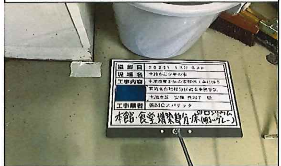
本館 食堂増築部分 1階 床 ロンリウム(色;明るいグレー)① 補修後
