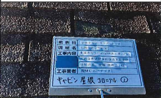
キャビン 1階 屋根 コロニアル① 採取後
