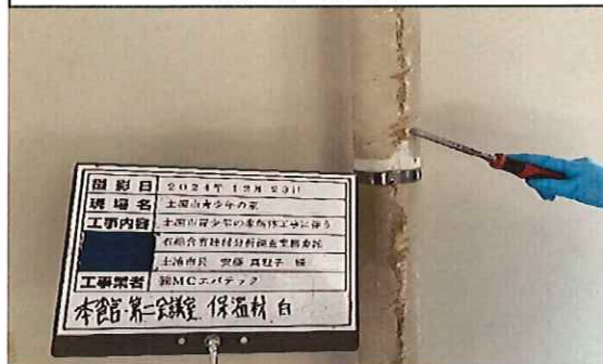
本館 第二会議室 1階 配管(白) 保温材 採取中
