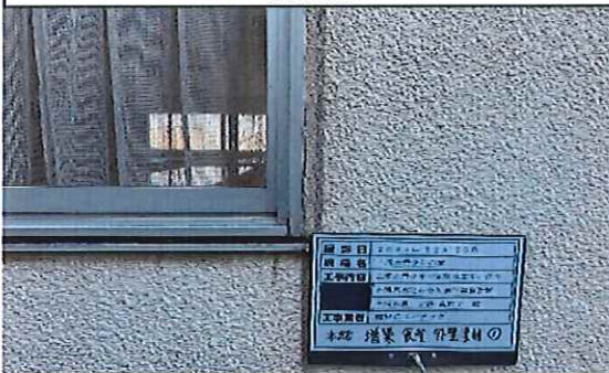
本館外部(増築;食堂) 1階 外壁 塗材① 採取前
