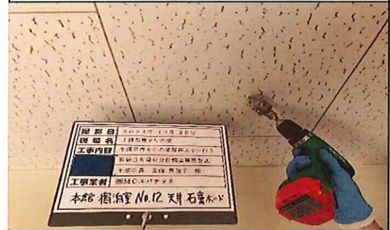
本館 宿泊室No.12 2階 天井 新;石膏ボード③ 採取中
