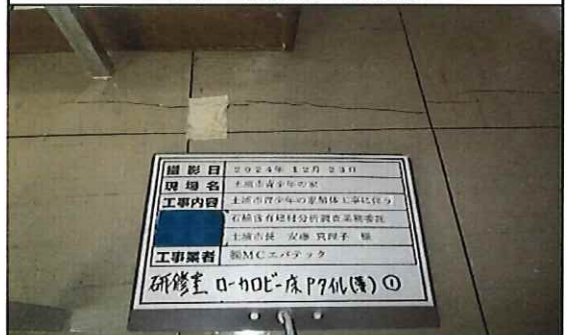
研修室 ローカ・ロビー 1階 床 Pタイル(薄)① 補修後
