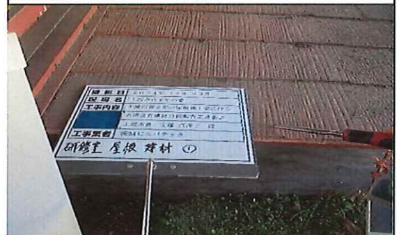
研修室外部 1階 屋根 コロニアル葺き① 採取中
