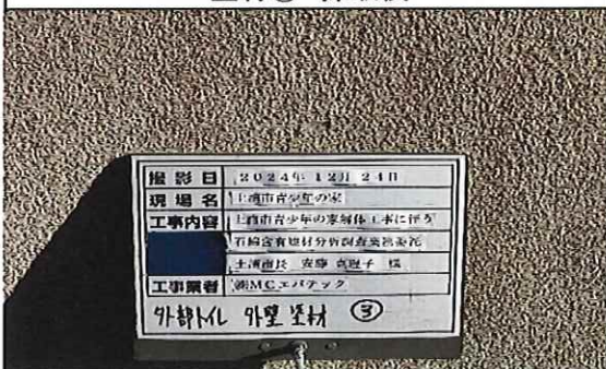
外部トイレ(竣工年1979年) 1階 外壁 塗材③ 採取後
