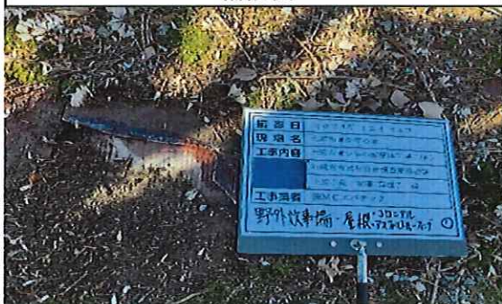
野外炊事場 1階 屋根 コロニアル① 補修後
