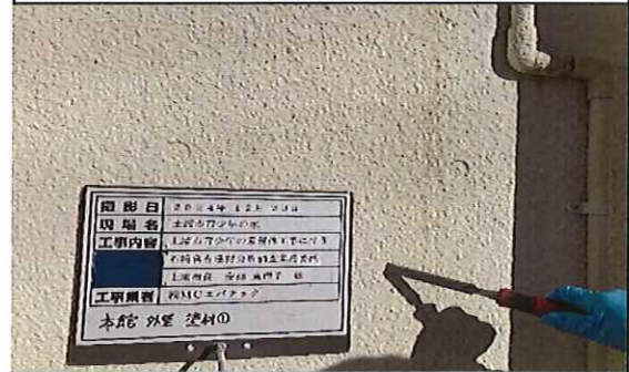
本館外部 1階 外壁 塗材① 採取中
