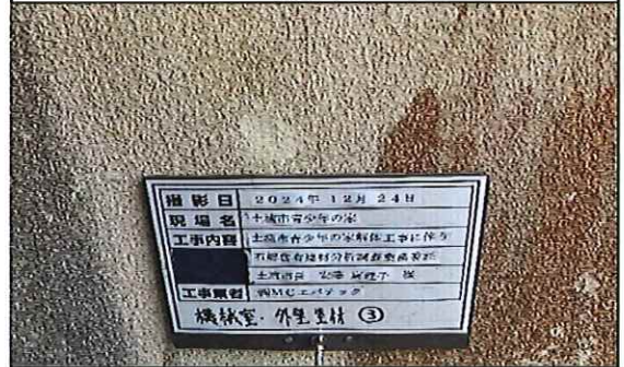
機械室 1階 外壁 塗材③ 補修後
