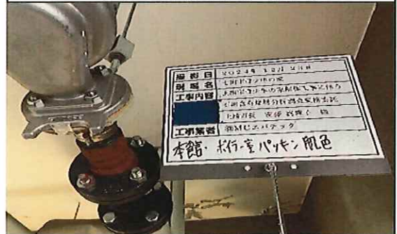
本館 ボイラー室 1階 配管 パッキン(色;肌色)① 補修後
