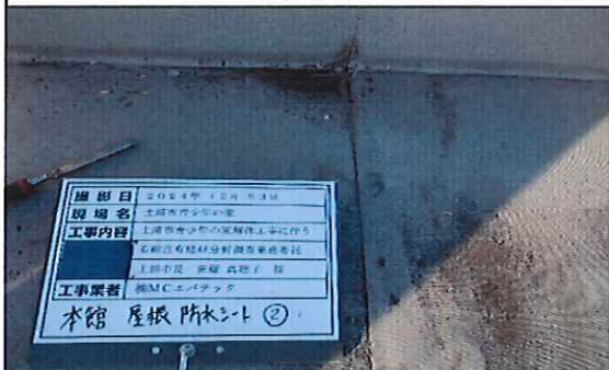
本館外部 1階 屋根 防水シート② 採取中
