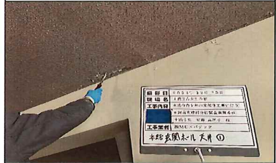
本館 玄関ホール 1階 天井 蛭石吹付① 採取中
