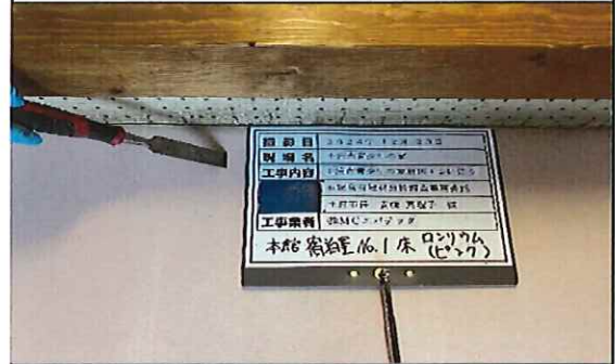
本館 宿泊室No.1 1階 床 ロンリウム(色;ピンク)① 採取中
