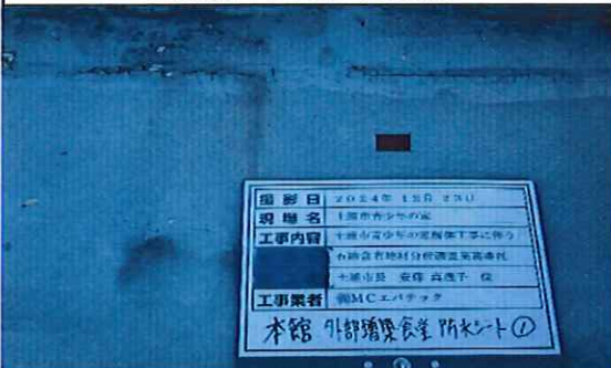
本館外部(増築;食堂) 1階 屋根 防水シート① 採取後
