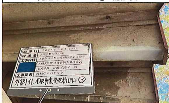
外部トイレ(竣工年1986年) 1階 屋根 軒裏 発泡ポリエチレン③ 補修後
