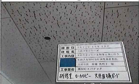
研修室 ローカ・ロビー 1階 天井 旧;石膏ボード② 採取後
