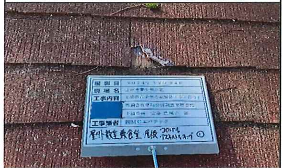
屋外教室兼食堂 1階 屋根 アスファルトルーフィング① 補修後
