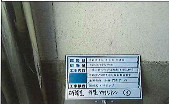
研修室外部 外壁 アクリルリシン③ 採取後
