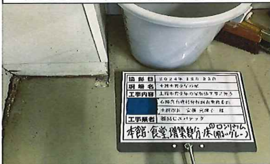
本館 食堂増築部分 1階 床 ロンリウム(色;明るいグレー)① 採取後
