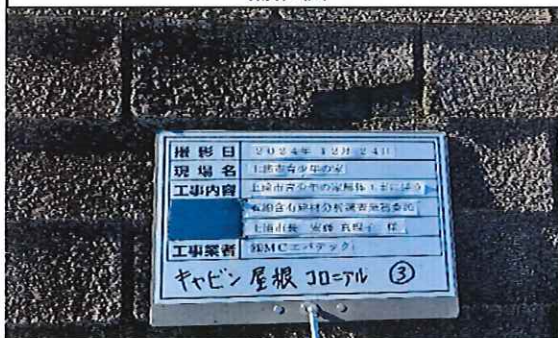
キャビン 1階 屋根 コロニアル③ 補修後
