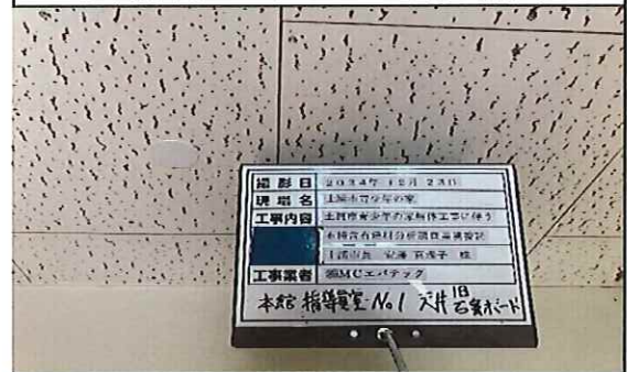
本館 指導員室No.1 1階 天井 旧;石膏ボード(ジブトーン)② 補修後
