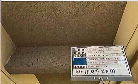
本館 廊下 1階 天井 蛭石吹付② 採取前
