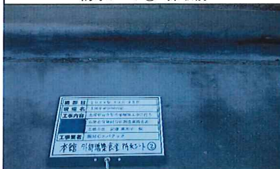
本館外部(増築;食堂) 1階 屋根 防水シート② 採取前
