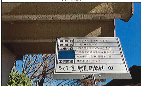
シャワー室 1階 軒裏 断熱材① 採取前
