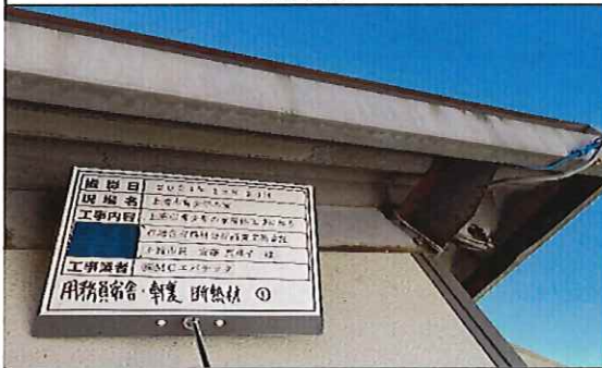
用務員宿舎 1階 軒裏 断熱材① 採取後
