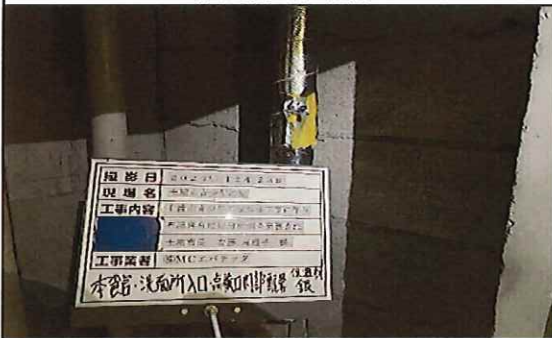
本館 洗面所入口 1階 点検口内部配管(銀) 保温材 採取後
