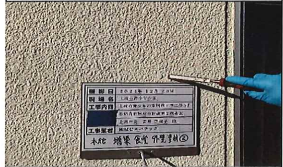
本館外部(増築;食堂) 1階 外壁 塗材② 採取中
