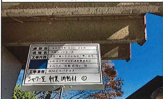
シャワー室 1階 軒裏 断熱材① 採取後
