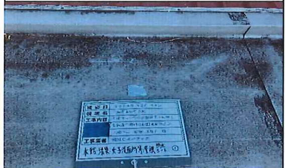
本館外部(増築;女子洗面所等) 1階 屋根 防水シート① 補修後
