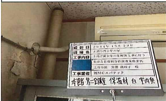
本館 第二会議室 1階 室内奥 配管(白) 保温材 採取前
