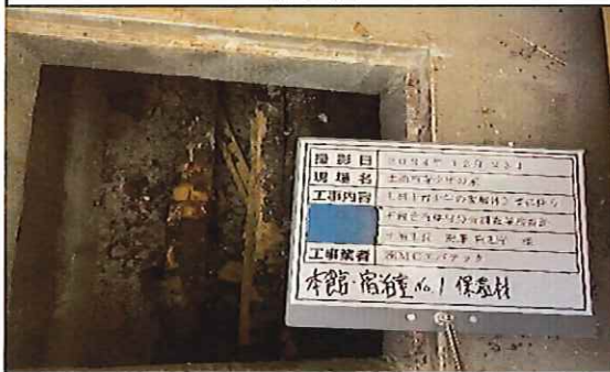
本館 宿泊室No.1 1階 床下配管 保温材 採取後
