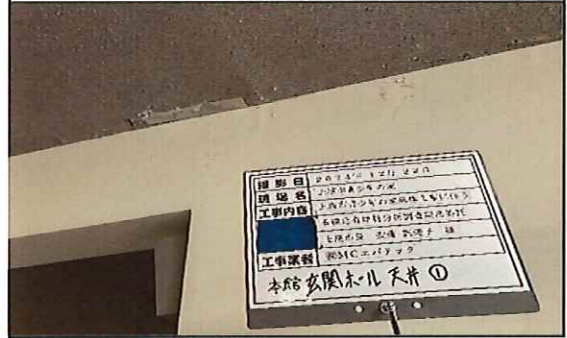
本館 玄関ホール 1階 天井 蛭石吹付① 補修後
