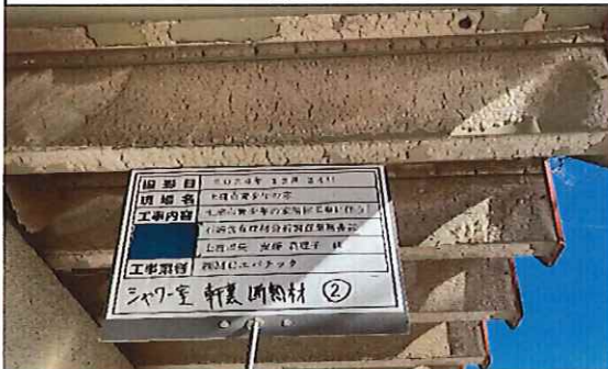
シャワー室 1階 軒裏 断熱材② 採取後
