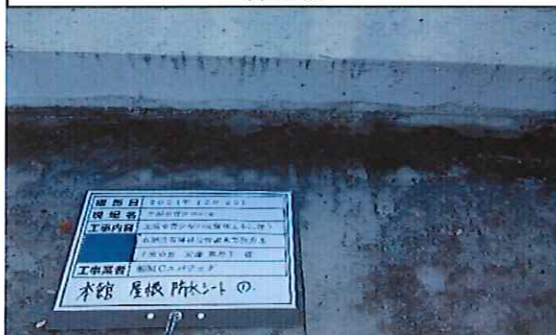
本館外部 1階 屋根 防水シート① 採取前
