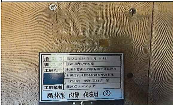
機械室 1階 内部 保温材② 採取後
