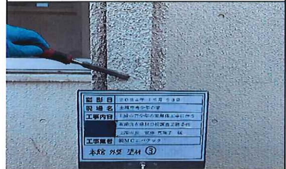
本館外部 1階 外壁 塗材③ 採取中
