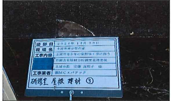
研修室外部 1階 屋根 コロニアル葺き③ 補修後
