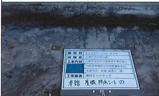
本館外部 1階 屋根 防水シート① 採取後
