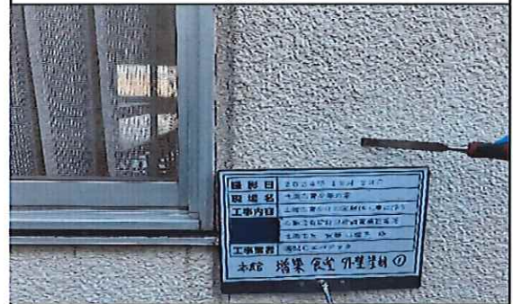
本館外部(増築;食堂) 1階 外壁 塗材① 採取中
