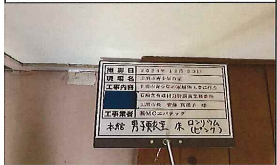
本館 男子脱衣室 1階 床 ロンリウム(色;ピンク)③ 補修後
