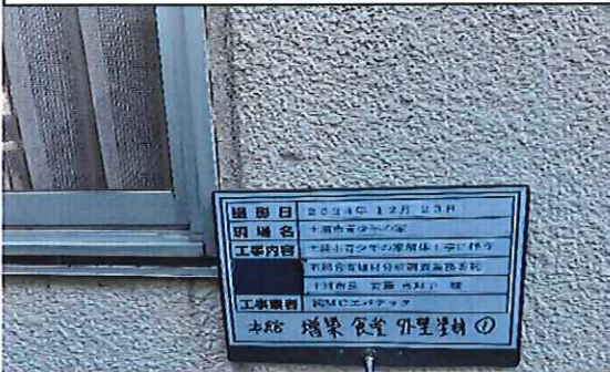
本館外部(増築;食堂) 1階 外壁 塗材① 採取後
