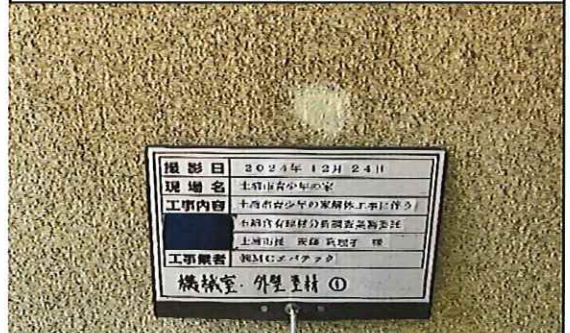
機械室 1階 外壁 塗材① 補修後
