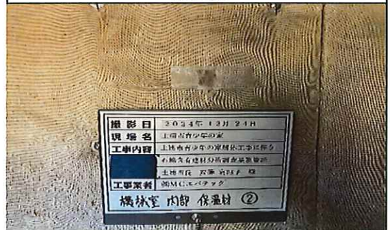
機械室 1階 内部 保温材② 補修後
