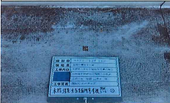
本館外部(増築;女子洗面所等) 1階 屋根 防水シート① 採取後
