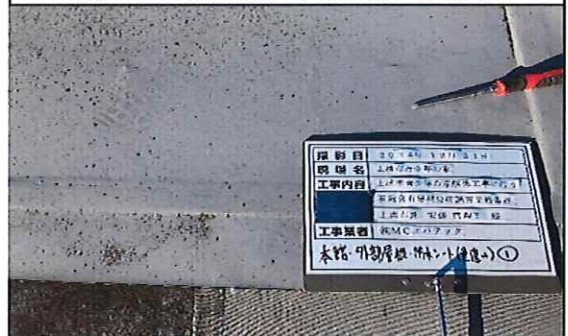
本館外部 2階 屋根 防水シート(色違い箇所)① 採取中
