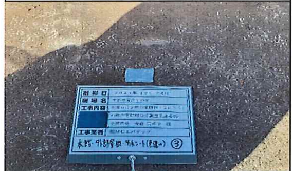
本館外部 2階 屋根 防水シート(色違い箇所)③ 補修後
