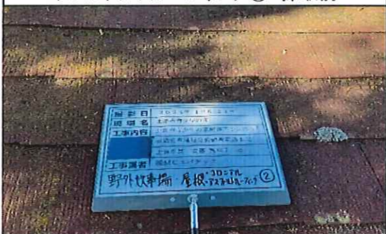
野外炊事場 1階 屋根 アスファルトルーフィング② 採取前
