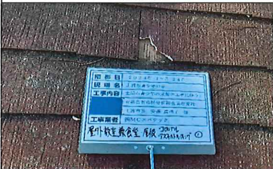
屋外教室兼食堂 1階 屋根 コロニアル① 採取後
