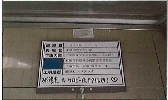
研修室 ローカ・ロビー 1階 床 Pタイル(薄)② 補修後
