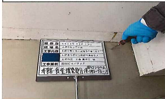
本館 食堂増築部分 1階 床 ロンリウム(色;明るいグレー)② 採取中
