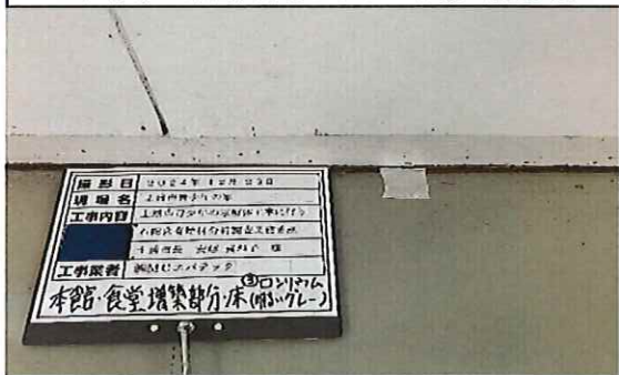
本館 食堂増築部分 1階 床 ロンリウム(色;明るいグレー)③ 補修後
