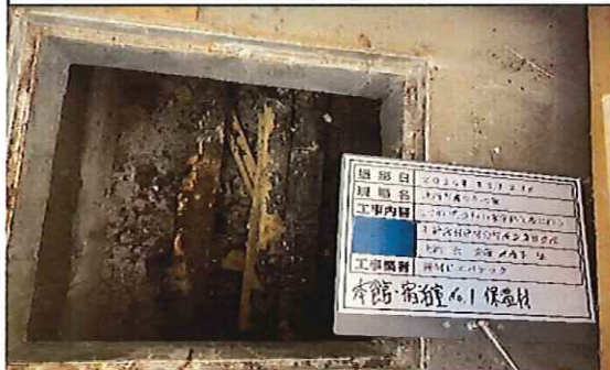
本館 宿泊室No.1 1階 床下配管 保温材 採取前
