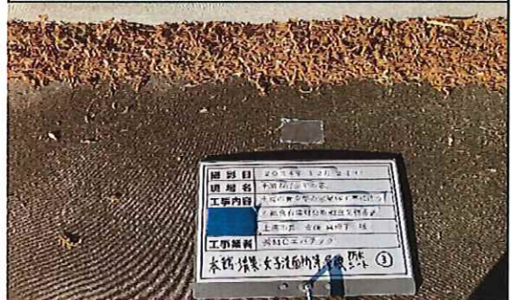
本館外部(増築;女子洗面所等) 1階 屋根 防水シート③ 補修後
