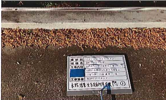
本館外部(増築;女子洗面所等) 1階 屋根 防水シート③ 採取前
