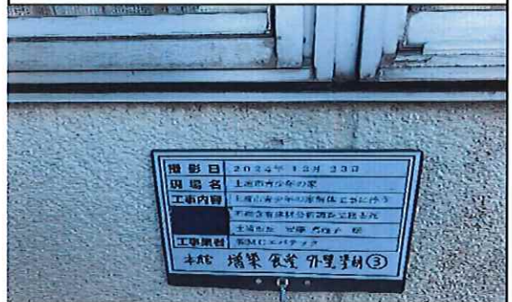
本館外部(増築;食堂) 1階 外壁 塗材③ 補修後
