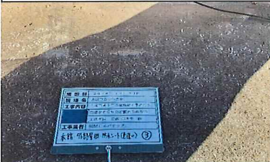
本館外部 2階 屋根 防水シート(色違い箇所)③ 採取後
