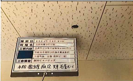
本館 宿泊室No.12 2階 天井 新;石膏ボード③ 採取後
