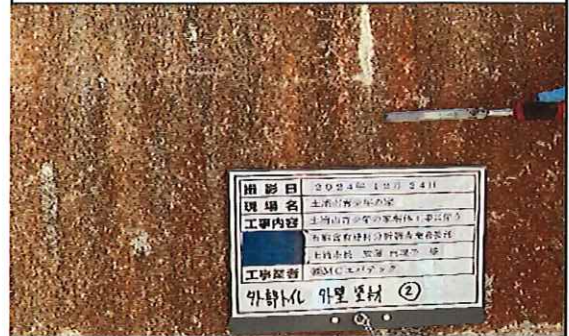
外部トイレ(竣工年1979年) 1階 外壁 塗材② 採取中
