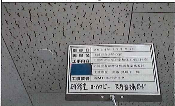
研修室 ローカ・ロビー 1階 天井 旧;石膏ボード② 補修後
