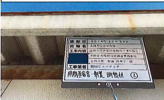
用務員宿舎 1階 軒裏 断熱材② 採取前
