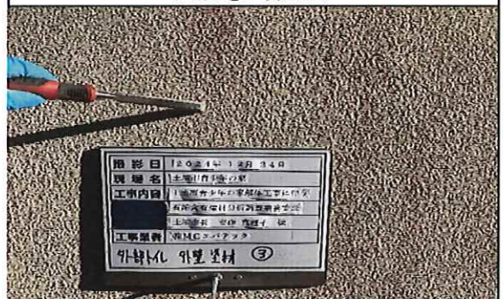
外部トイレ(竣工年1979年) 1階 外壁 塗材③ 採取中
