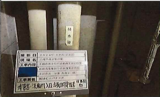
本館 洗面所入口 1階 点検口内部配管(白) 保温材 採取前
