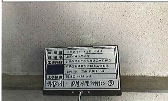
外部トイレ(竣工年1986年) 1階 内壁 アクリルリシン③ 補修後
