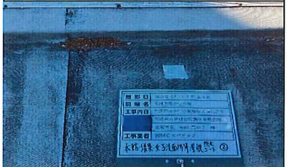
本館外部(増築;女子洗面所等) 1階 屋根 防水シート② 補修後
