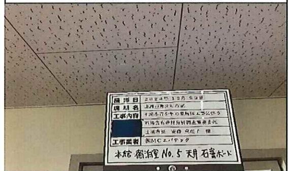
本館 宿泊室No.5 2階 天井 新;石膏ボード① 補修後
