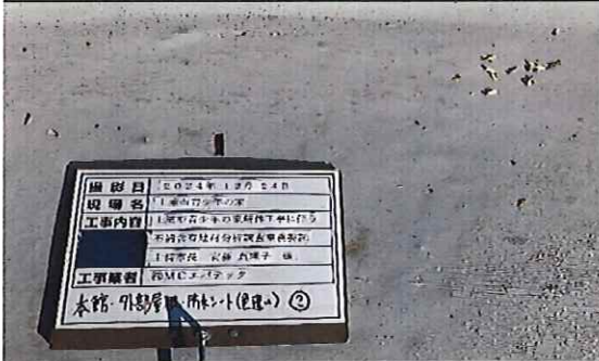
本館外部 2階 屋根 防水シート(色違い箇所)② 採取後
