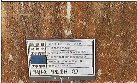
外部トイレ(竣工年1979年) 1階 外壁 塗材② 採取後
