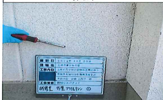
研修室外部 外壁 アクリルリシン① 採取中
