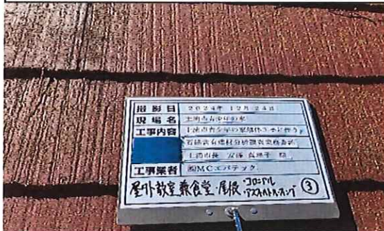
屋外教室兼食堂 1階 屋根 アスファルトルーフィング③ 採取前
