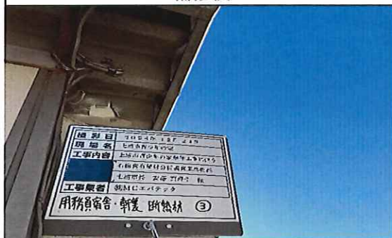
用務員宿舎 1階 軒裏 断熱材③ 補修後
