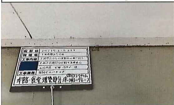
本館 食堂増築部分 1階 床 ロンリウム(色;明るいグレー)③ 採取後
