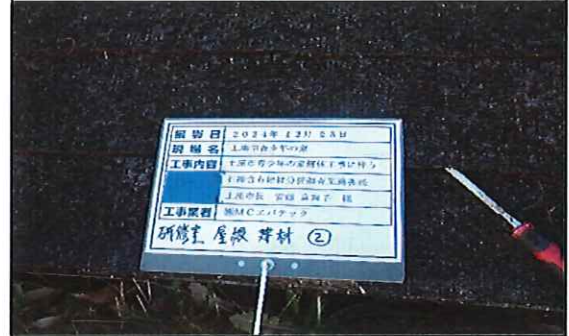
研修室外部 1階 屋根 コロニアル葺き② 採取中
