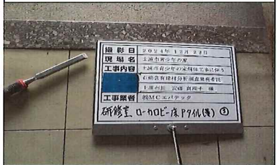
研修室 ローカ・ロビー 1階 床 Pタイル(薄)③ 採取中
