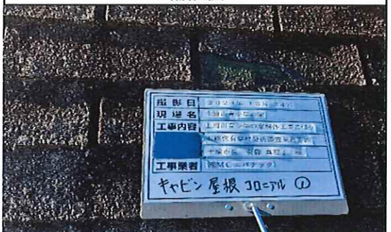
キャビン 1階 屋根 コロニアル① 補修後
