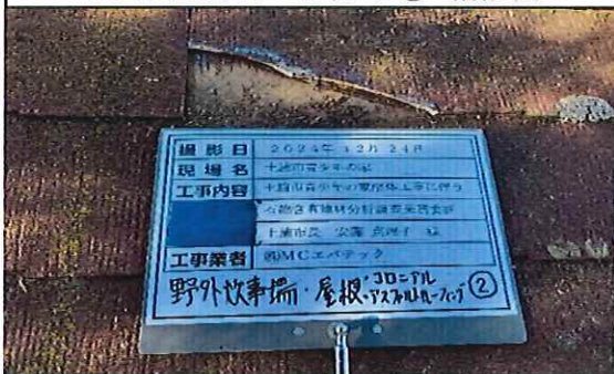
野外炊事場 1階 屋根 アスファルトルーフィング② 補修後
