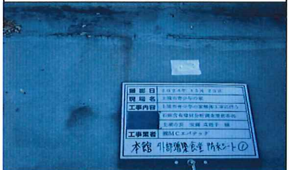
本館外部(増築;食堂) 1階 屋根 防水シート① 補修後
