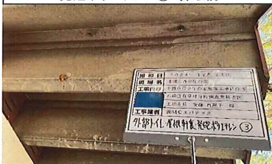
外部トイレ(竣工年1986年) 1階 屋根 軒裏 発泡ポリエチレン③ 採取前
