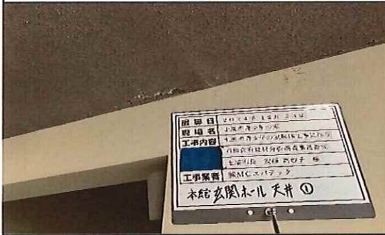
本館 玄関ホール 1階 天井 蛭石吹付① 採取後
