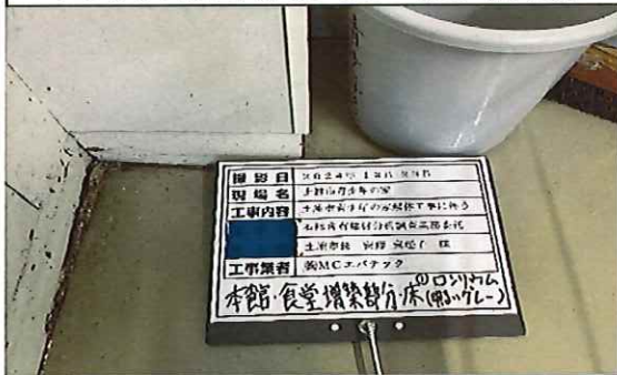
本館 食堂増築部分 1階 床 ロンリウム(色;明るいグレー)① 採取前
