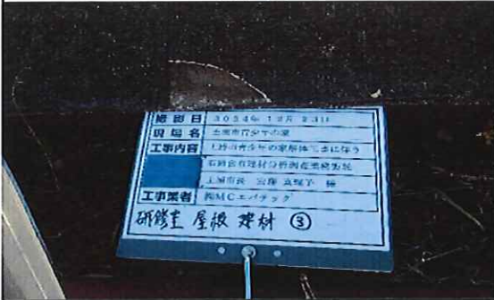
研修室外部 1階 屋根 コロニアル葺き③ 採取後
