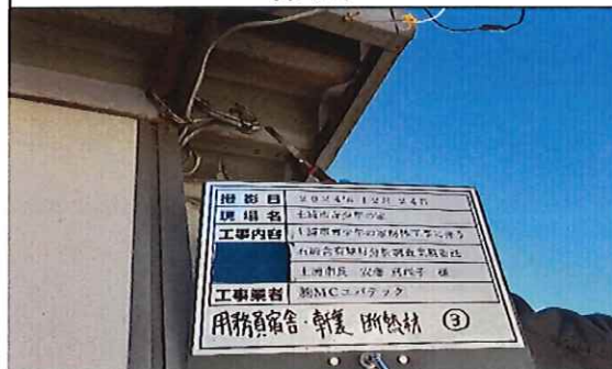
用務員宿舎 1階 軒裏 断熱材③ 採取中
