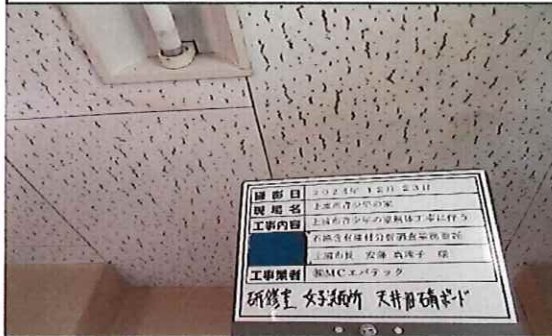
研修室 女子洗面所 1階 天井 旧;石膏ボード③ 採取前
