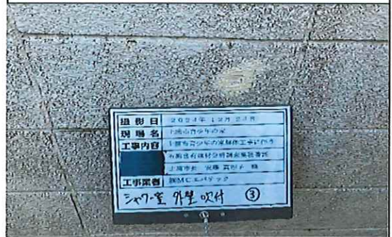
シャワー室 外壁 吹付③ 補修後
