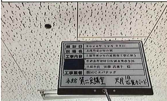
本館 第二会議室 1階 天井 旧;石膏ボード(ジブトーン)③ 採取後
