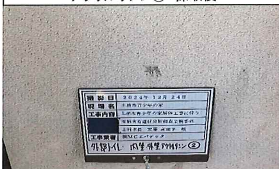
外部トイレ(竣工年1986年) 1階 外壁 アクリルリシン② 採取後
