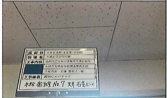
本館 宿泊室No.7 2階 天井 新;石膏ボード② 補修後
