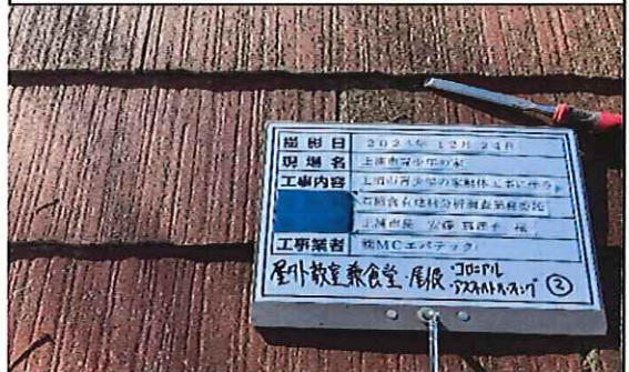
屋外教室兼食堂 1階 屋根 アスファルトルーフィング② 採取中
