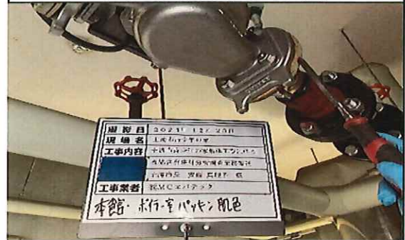
本館 ボイラー室 1階 配管 パッキン(色;肌色)① 採取中
