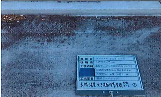
本館外部(増築;女子洗面所等) 1階 屋根 防水シート① 採取前
