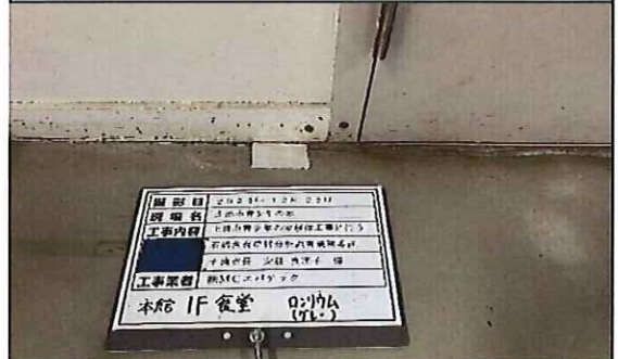
本館 食堂 1階 床 ロンリウム(色;グレー)③ 補修後
