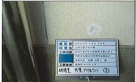
研修室外部 外壁 アクリルリシン③ 補修後
