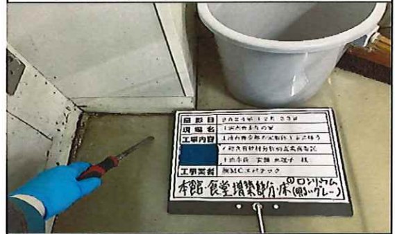
本館 食堂増築部分 1階 床 ロンリウム(色;明るいグレー)① 採取中
