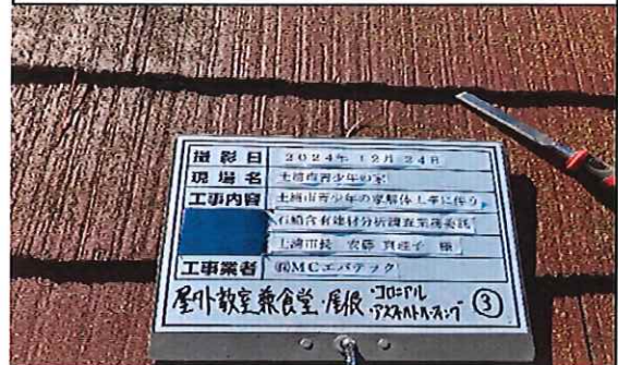
屋外教室兼食堂 1階 屋根 アスファルトルーフィング③ 採取中
