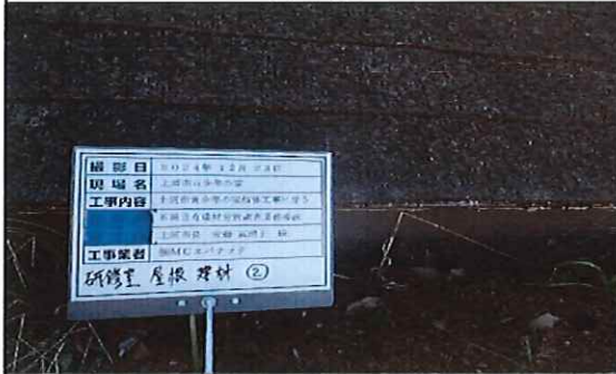
研修室外部 1階 屋根 コロニアル葺き② 採取前
