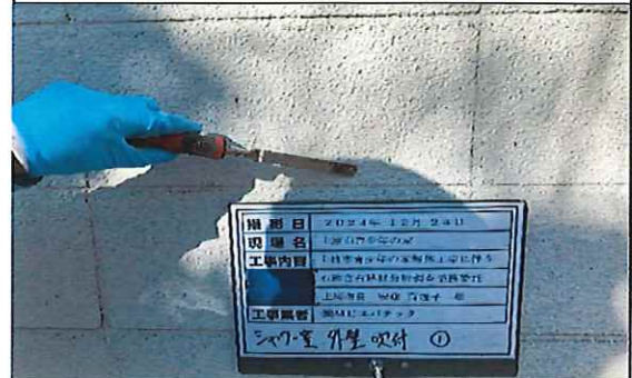
シャワー室 外壁 吹付① 採取中
