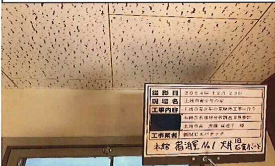
本館 宿泊室No.1 1階 天井 旧;石膏ボード(ジプトーン)① 採取前
