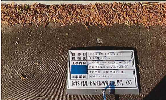
本館外部(増築;女子洗面所等) 1階 屋根 防水シート③ 採取後
