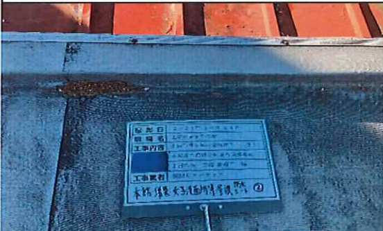
本館外部(増築;女子洗面所等) 1階 屋根 防水シート② 採取前
