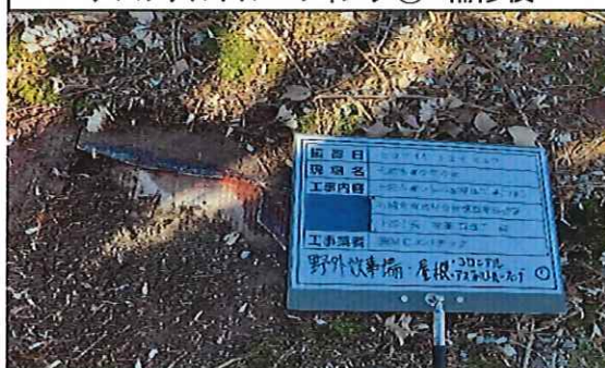
野外炊事場 1階 屋根 アスファルトルーフィング① 補修後
