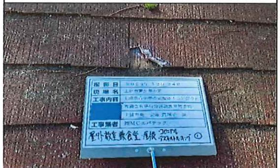
屋外教室兼食堂 1階 屋根 コロニアル① 補修後
