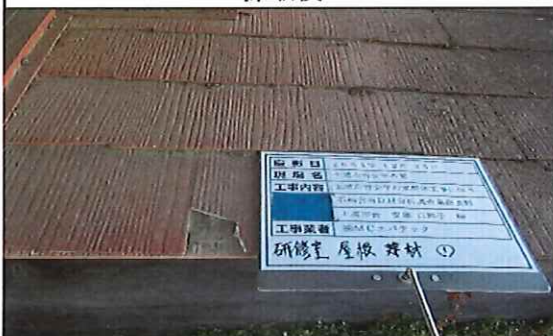
研修室外部 1階 屋根 コロニアル葺き① 採取後
