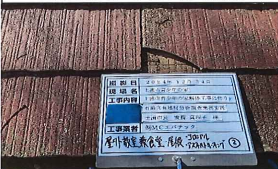
屋外教室兼食堂 1階 屋根 アスファルトルーフィング② 採取後
