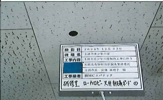
研修室 ローカ・ロビー 1階 天井 新;石膏ボード① 採取後
