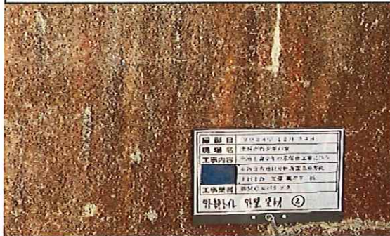
外部トイレ(竣工年1979年) 1階 外壁 塗材② 採取前
