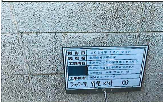
シャワー室 外壁 吹付③ 採取前
