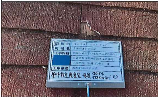
屋外教室兼食堂 1階 屋根 アスファルトルーフィング① 採取後
