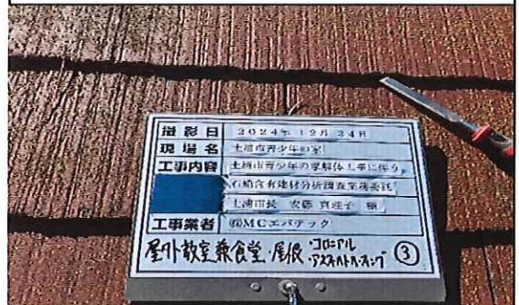
屋外教室兼食堂 1階 屋根 コロニアル③ 採取中
