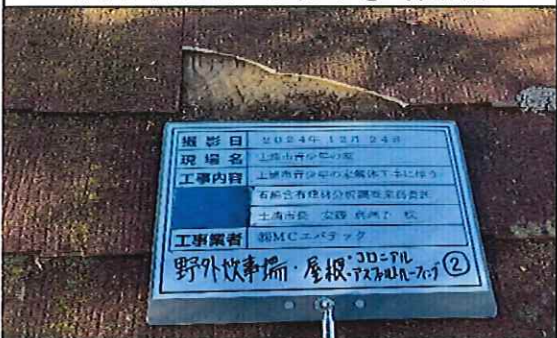
野外炊事場 1階 屋根 アスファルトルーフィング② 採取後
