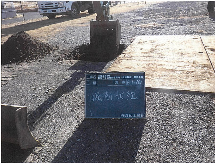
写真区分:施工状況写真 写真タイトル:掘削状況 撮影箇所:B1-10
