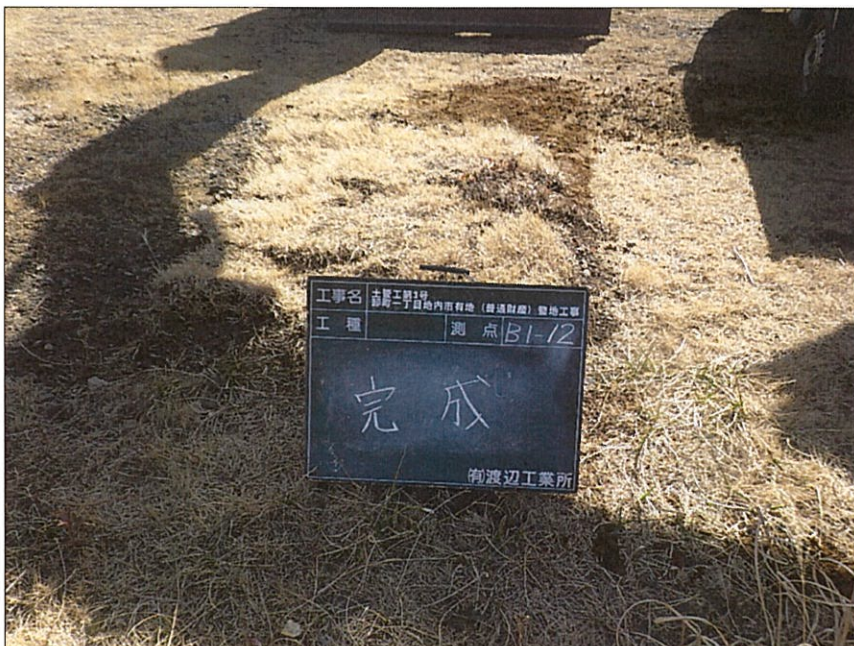
写真区分:着手前及び完成写真 写真タイトル:完成 撮影箇所:B1-12
