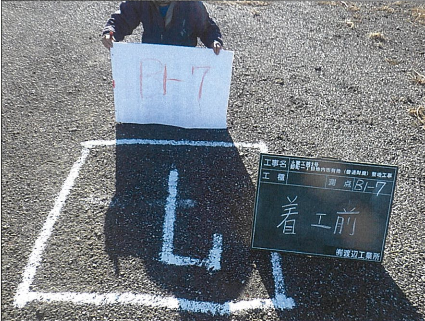
写真区分:着手前及び完成写真 写真タイトル:着工前 撮影箇所:B1-7
