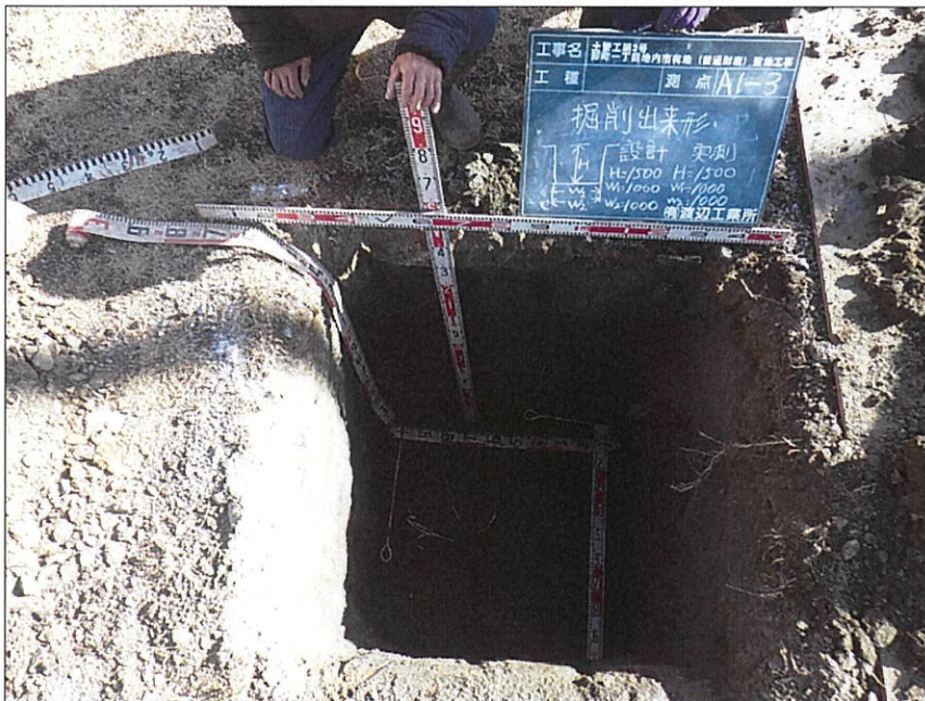
写真区分:出来形管理写真 写真タイトル:掘削出来形 撮影箇所:A1-3 施工管理値:設計H=1500 W1=1000 W2=1000 実測H=1500 W1=1000 W2=1000
