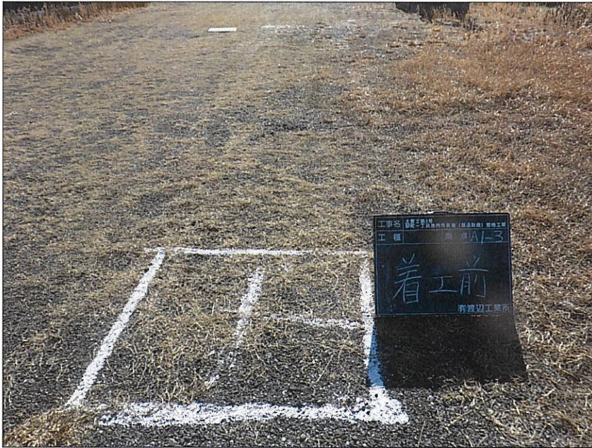
写真区分:着手前及び完成写真 写真タイトル:着工前 撮影箇所:A1-3
