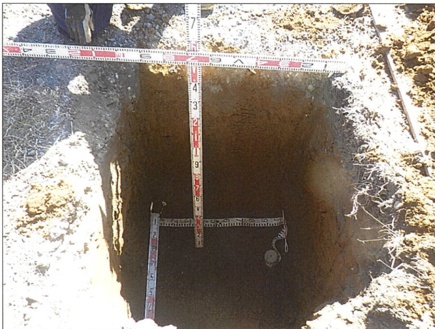
写真区分:出来形管理写真 写真タイトル:掘削出来形 撮影箇所:B1-2
