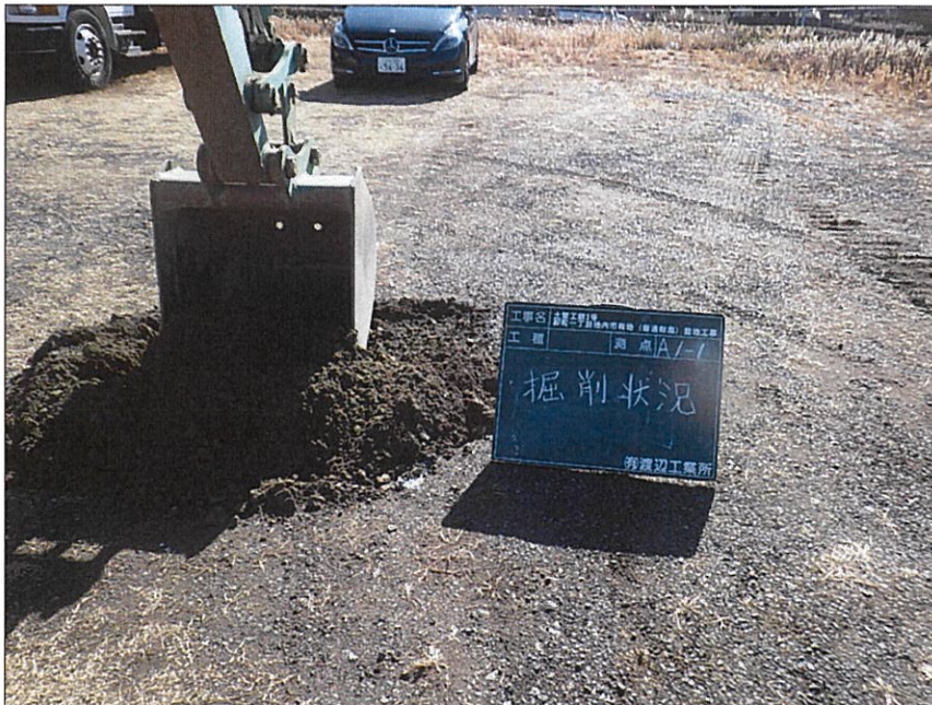
写真区分: 施工状況写真 細別: 立会人 写真タイトル: 掘削状況 撮影箇所: A1-1
