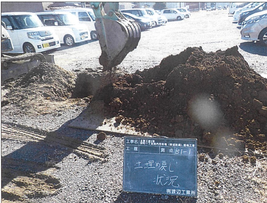
写真区分:施工状況写真 写真タイトル:土埋戻し状況 撮影箇所:B1-1
