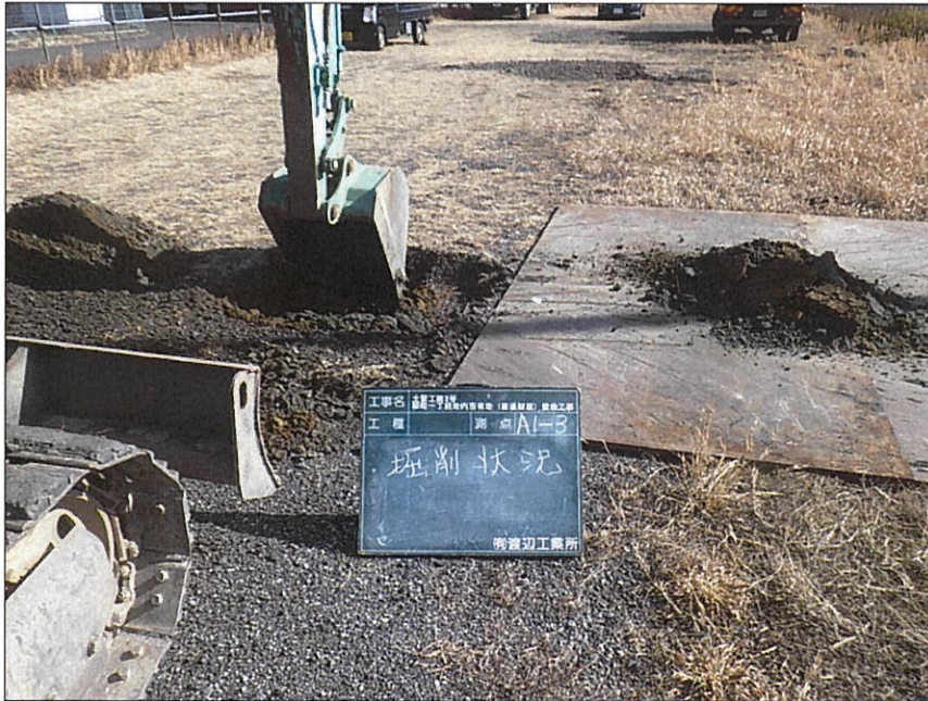
写真区分: 施工状況写真 写真タイトル: 掘削状況 撮影箇所: A1-3
