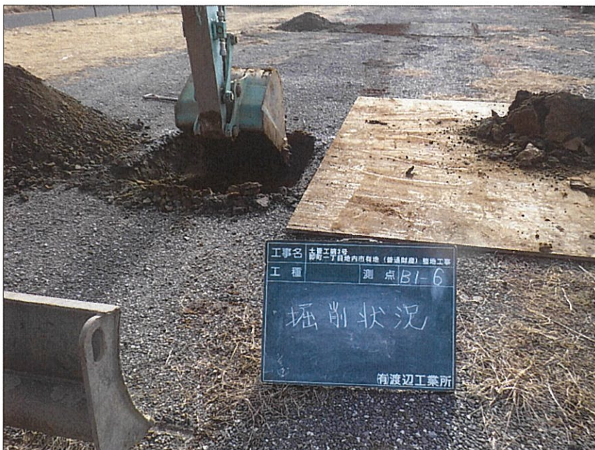
写真区分: 施工状況写真 写真タイトル: 掘削状況 撮影箇所: B1-6
