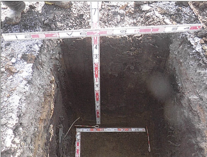
写真区分:出来形管理写真 写真タイトル:掘削出来形 撮影箇所:B1-6 施工管理値:設計H=1500 W1 =1000 W2=1000 実測H=1500 W1=1000 W2=1000
