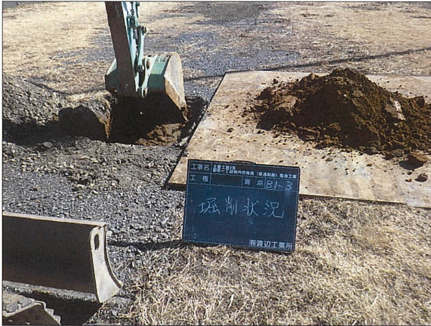
写真区分: 施工状況写真 写真タイトル: 掘削状況 撮影箇所: B1-3
