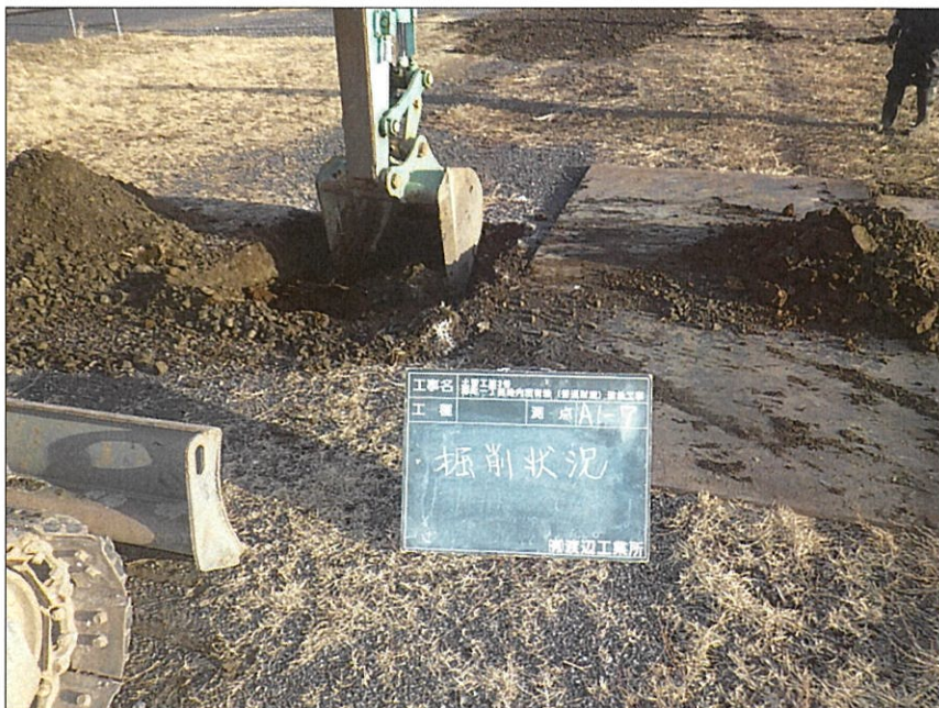
写真区分: 施工状況写真 写真タイトル: 掘削状況 撮影箇所: A1-7
