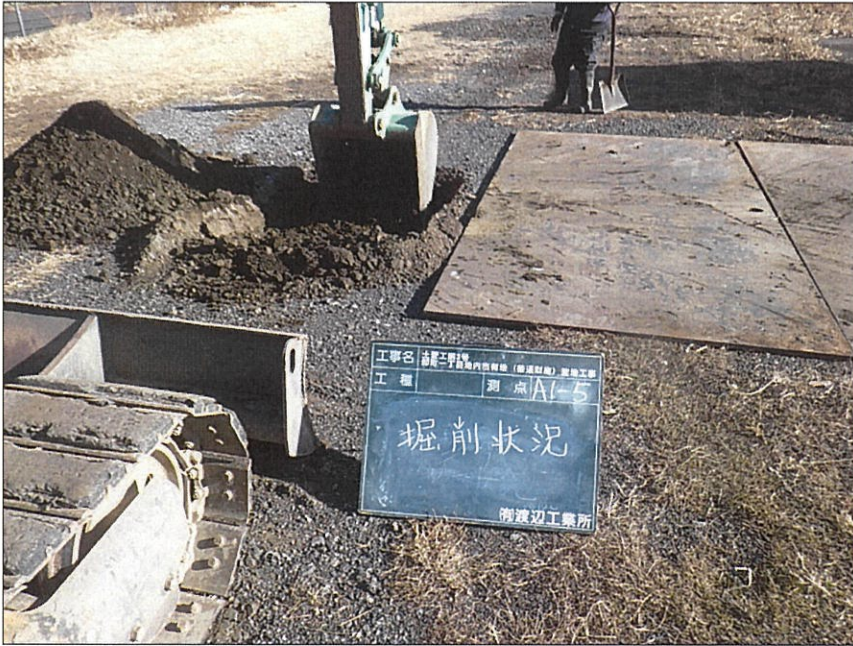
写真区分: 施工状況写真 写真タイトル: 掘削状況 撮影箇所: A1-5
