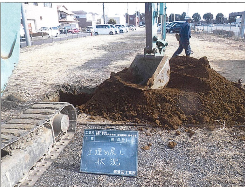
写真区分: 施工状況写真 写真タイトル: 土埋戻し状況 撮影箇所: B1-4
