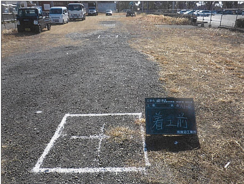
写真区分:着手前及び完成写真 写真タイトル:着工前 撮影箇所:A1-6
