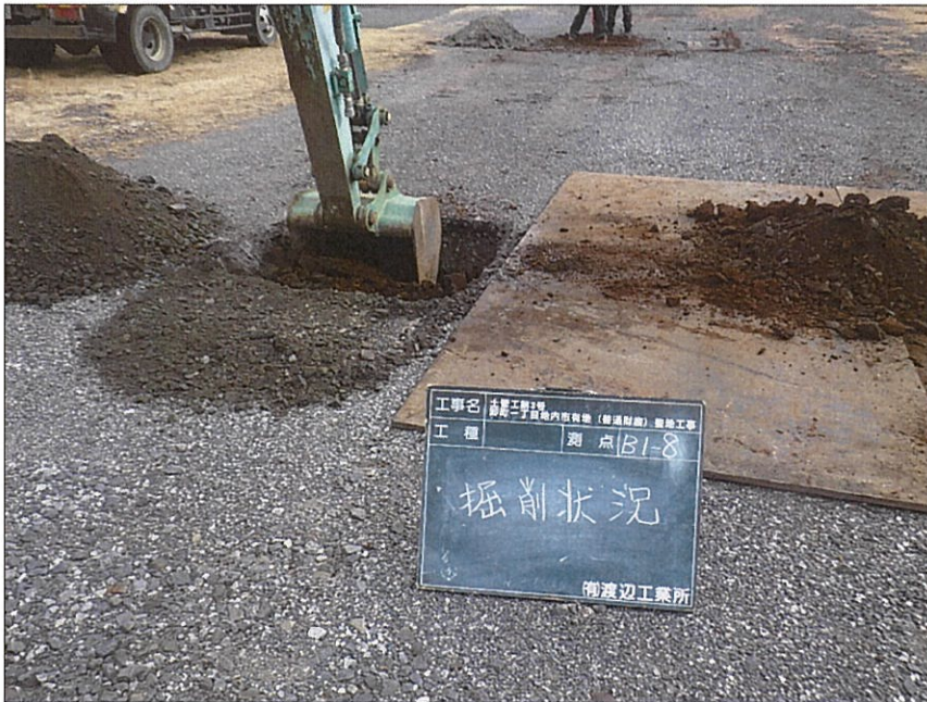
写真区分: 施工状況写真 写真タイトル: 掘削状況 撮影箇所: B1-8
