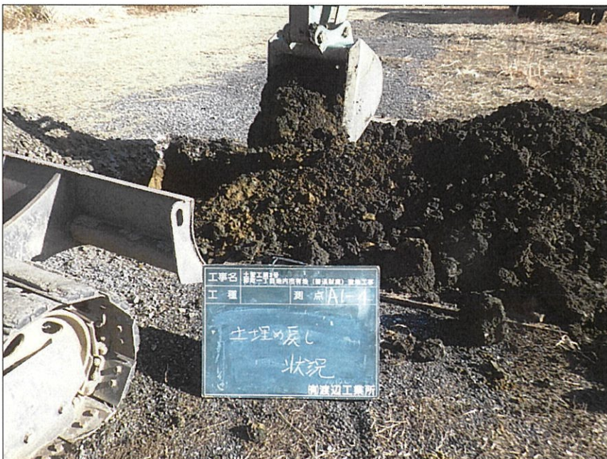
写真区分: 施工状況写真 写真タイトル: 土埋戻し状況 撮影箇所: A1-4
