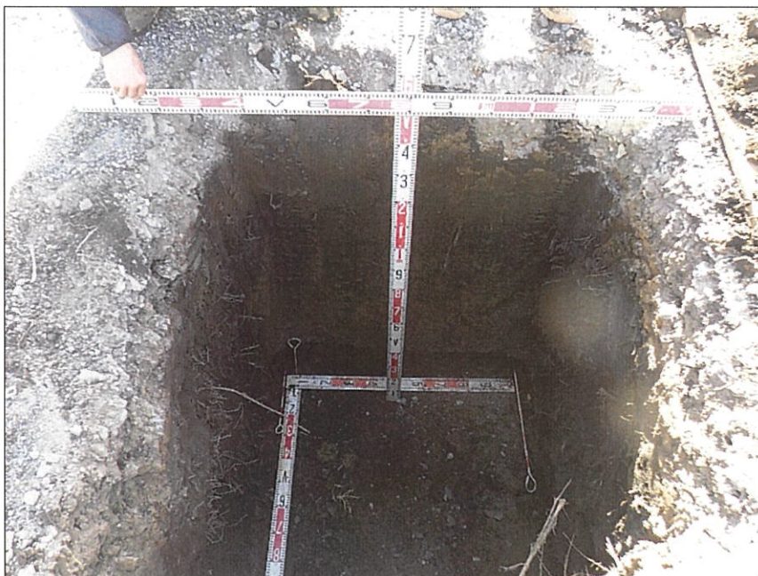
写真区分:出来形管理写真 写真タイトル:掘削出来形 撮影箇所:B1-10 施工管理値:設計H=1500 W1=1000 W2=1000 実測H=1500 W1=1000 W2=1000
