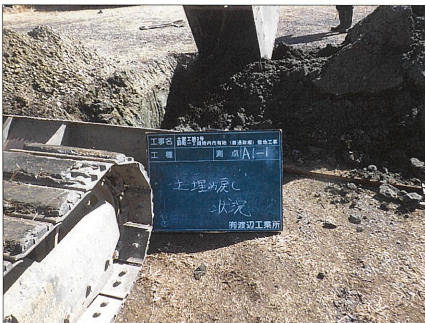
写真区分: 施工状況写真 写真タイトル: 土埋戻し状況 撮影箇所: A1-1
