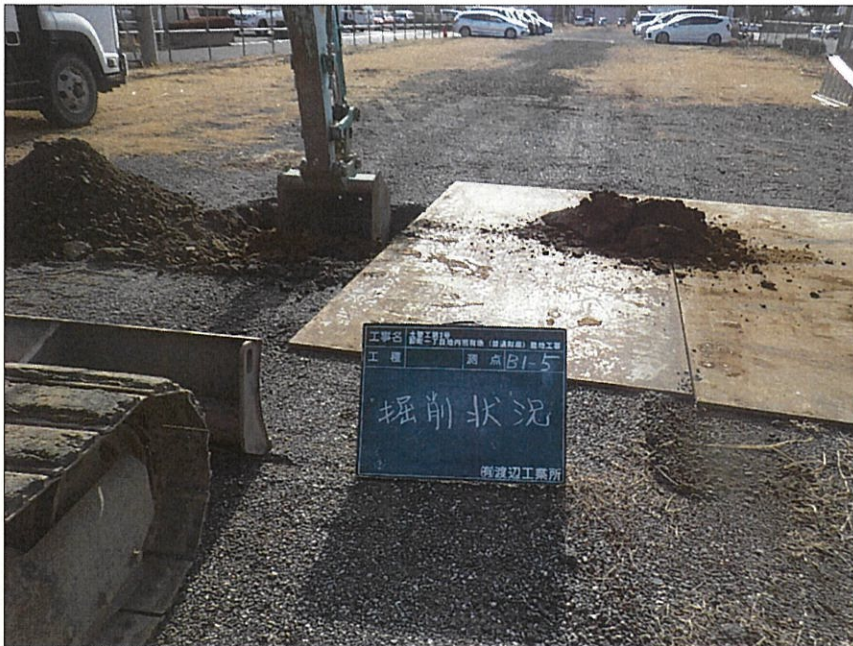
写真区分: 施工状況写真 写真タイトル: 掘削状況 撮影箇所: B1-5
