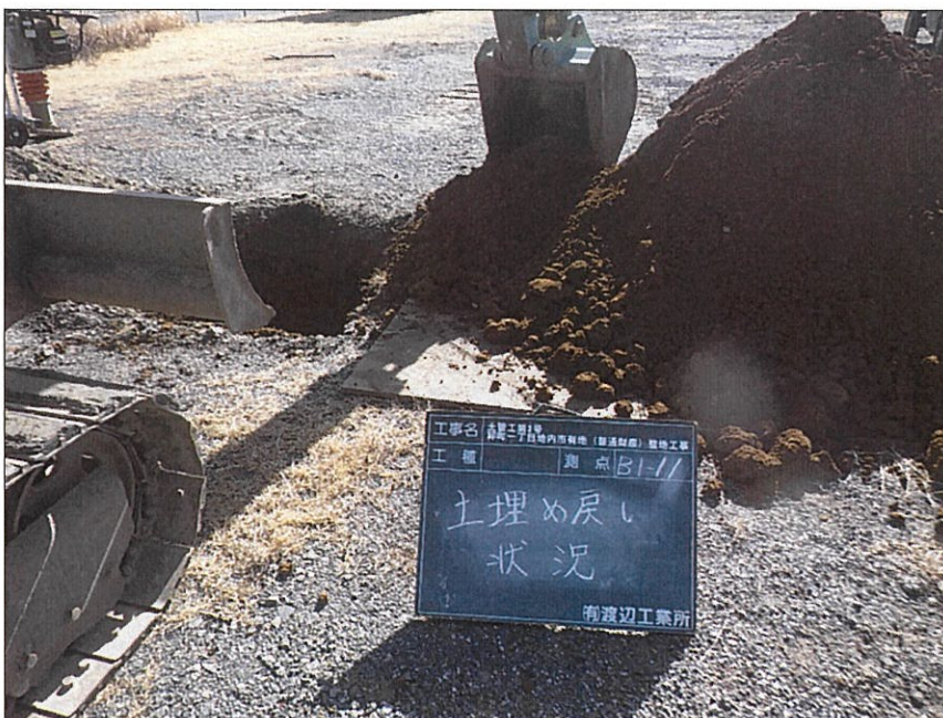
写真区分: 施工状況写真 写真タイトル: 土埋戻し状況 撮影箇所: B1-11
