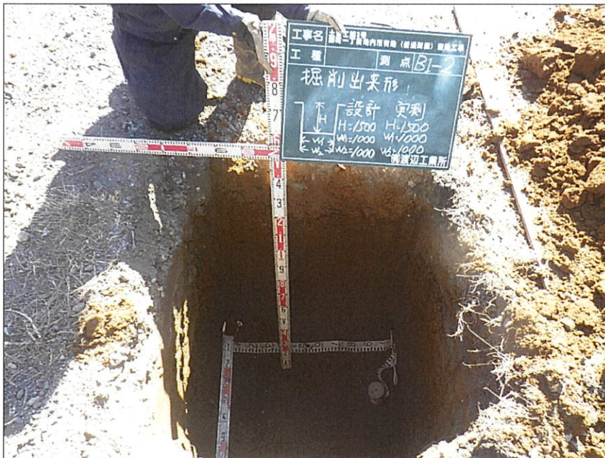
写真区分:出来形管理写真 写真タイトル:掘削出来形 撮影箇所:B1-2 施工管理値:設計H=1500 W1 =1000 W2=1000 実測H=1500 W1=1000 W2=1000
