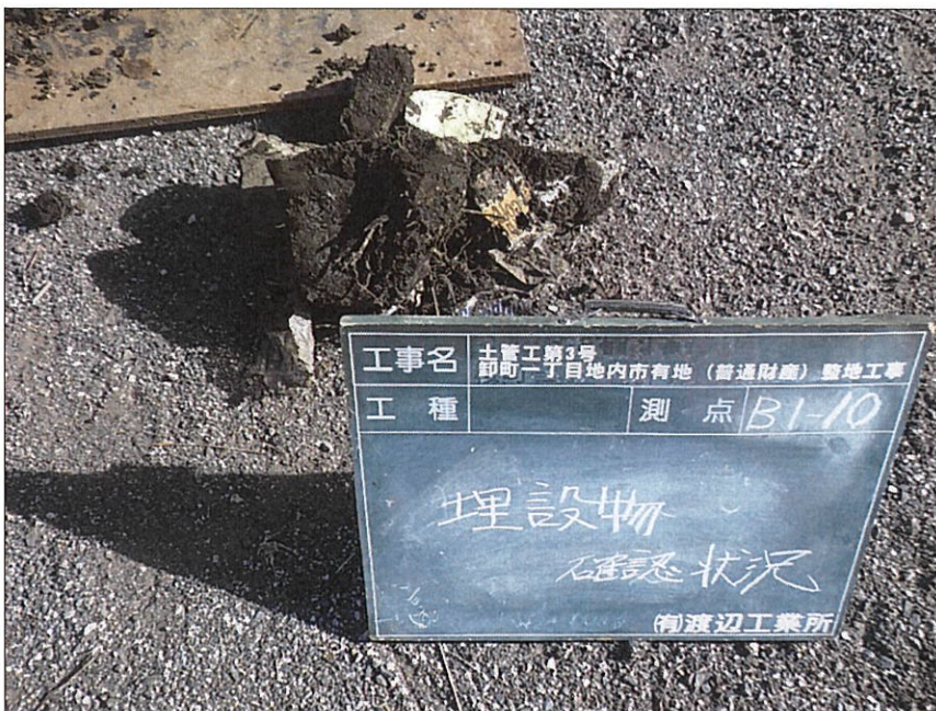
写真区分:施工状況写真 工種:B1-10 写真タイトル:埋設物確認状況 撮影箇所:B1-10
