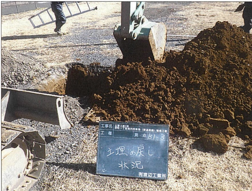
写真区分: 施工状況写真 写真タイトル: 土埋戻し状況 撮影箇所: B1-3
