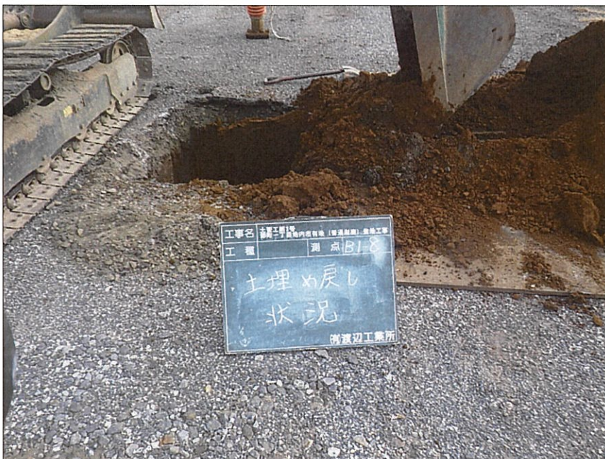
写真区分: 施工状況写真 写真タイトル: 土埋戻し状況 撮影箇所: B1-8
