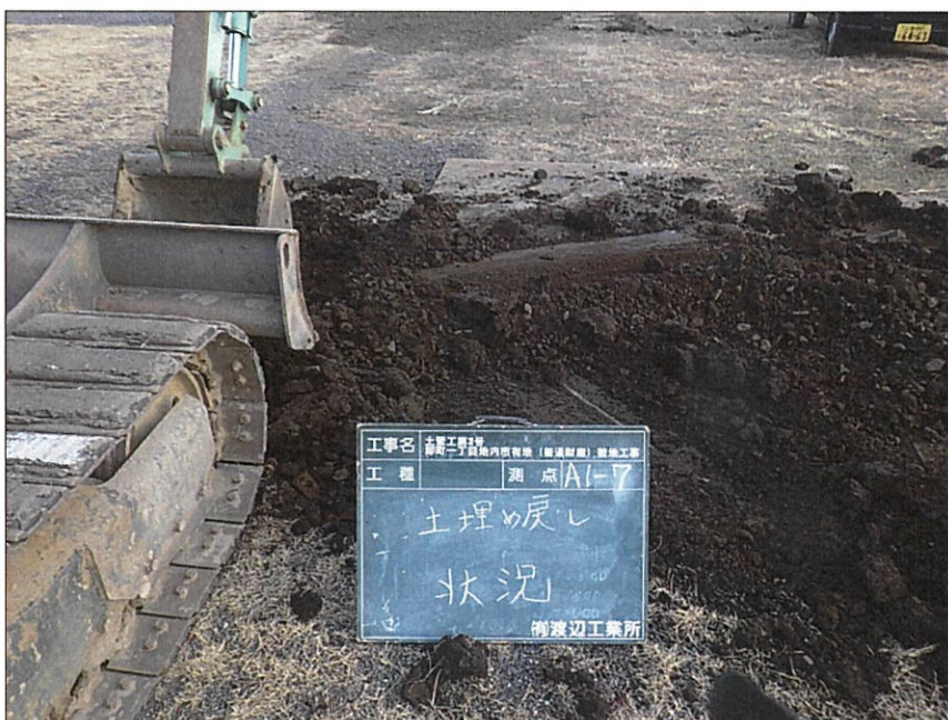
写真区分: 施工状況写真 写真タイトル: 土埋戻し状況 撮影箇所: A1-7
