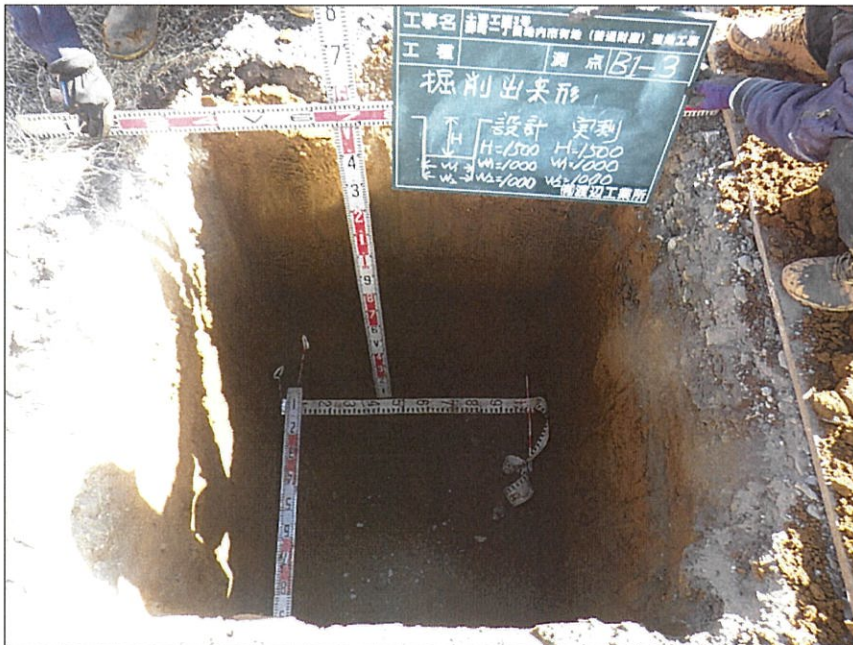
写真区分: 出来形管理写真 写真タイトル: 掘削出来形 撮影箇所: B1-3 施工管理値: 設計H=1500 W1=1000 W2=1000 実測H=1500 W1=1000 W2=1000
