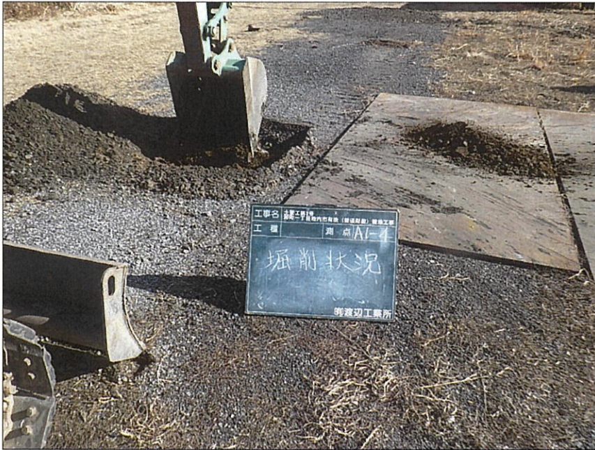
写真区分: 施工状況写真 写真タイトル: 掘削状況 撮影箇所: A1-4
