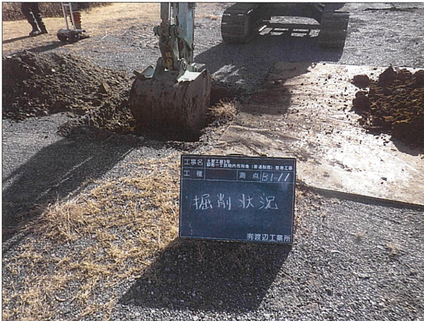
写真区分: 施工状況写真 写真タイトル: 掘削状況 撮影箇所: B1-11
