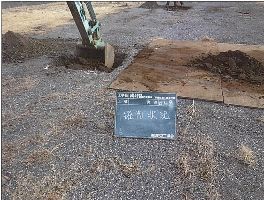
写真区分: 施工状況写真 写真タイトル: 掘削出来形 撮影箇所: B1-9
