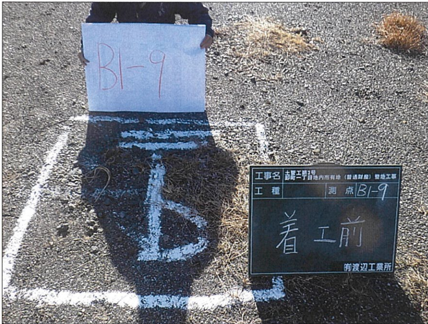
写真区分:着手前及び完成写真 写真タイトル:着工前 撮影箇所:B1-9
