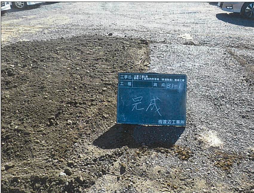
写真区分:着手前及び完成写真 写真タイトル:完成 撮影箇所:B1-1
