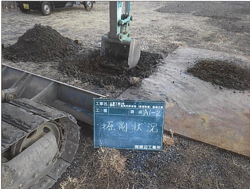
写真区分: 施工状況写真 写真タイトル: 掘削状況 撮影箇所: A1-2
