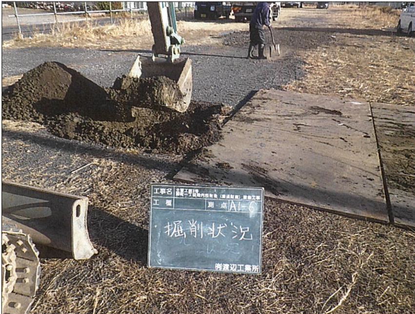
写真区分: 施工状況写真 写真タイトル: 掘削状況 撮影箇所: A1-6
