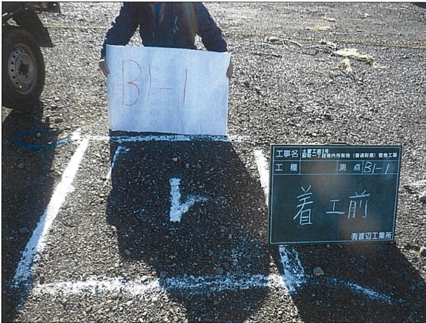
写真区分:着手前及び完成写真 写真タイトル:着工前 撮影箇所:B1-1
