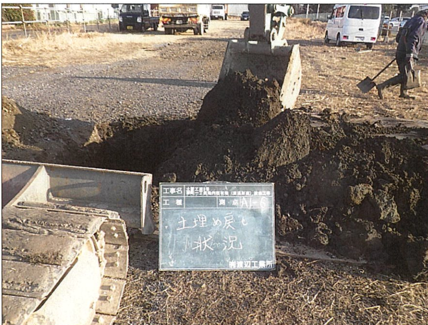
写真区分: 施工状況写真 写真タイトル: 土埋戻し状況 撮影箇所: A1-6
