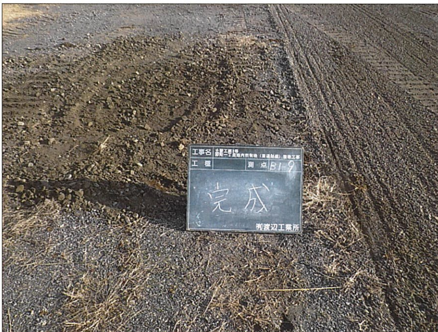
写真区分:着手前及び完成写真 写真タイトル:完成 撮影箇所:B1-9
