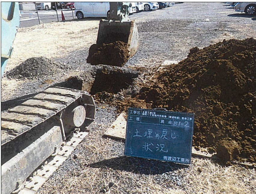
写真区分: 施工状況写真 写真タイトル: 土埋戻し状況 撮影箇所: B1-2
