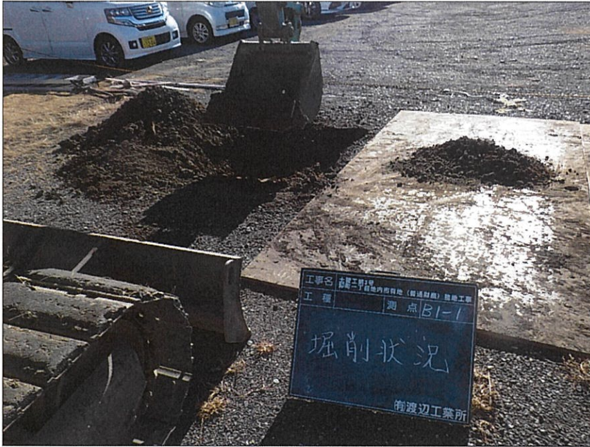
写真区分:施工状況写真 写真タイトル:掘削状況 撮影箇所:B1-1
