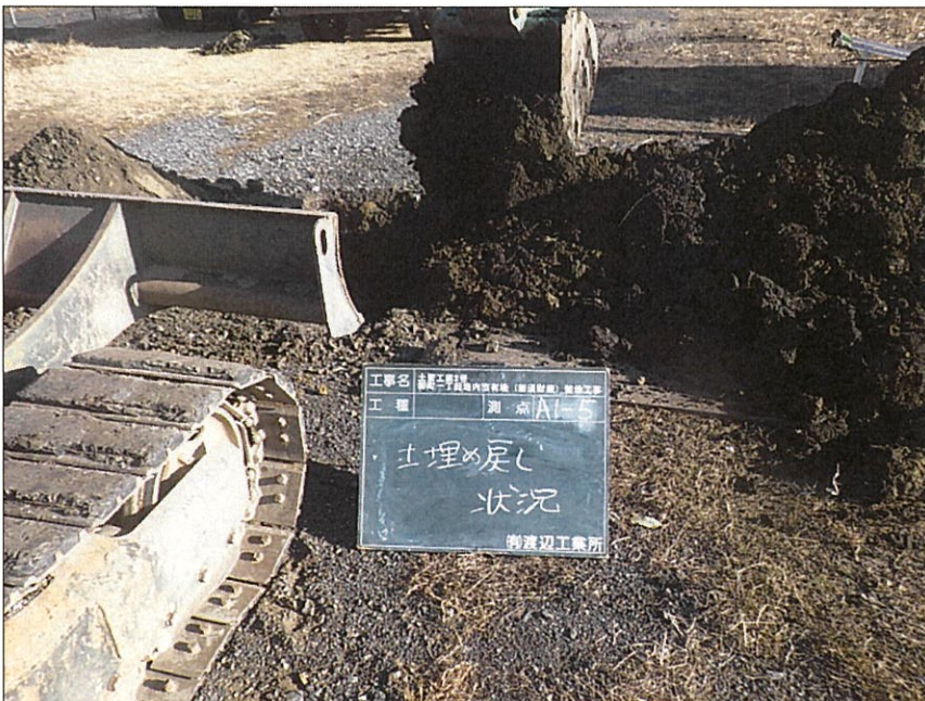
写真区分: 施工状況写真 写真タイトル: 土埋戻し状況 撮影箇所: A1-5
