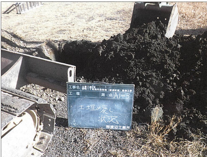
写真区分: 施工状況写真 写真タイトル: 土埋戻し状況 撮影箇所: A1-3
