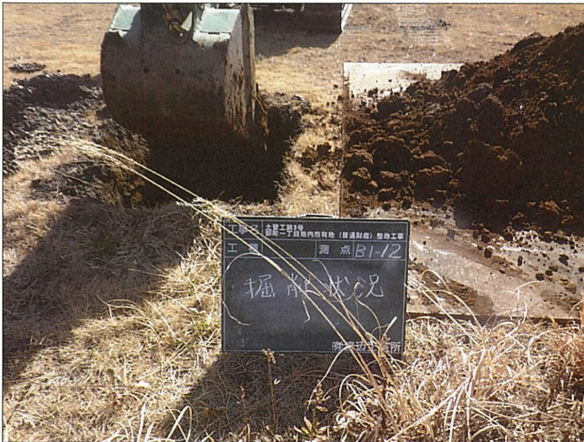
写真区分: 施工状況写真 写真タイトル: 掘削状況 撮影箇所: B1-12
