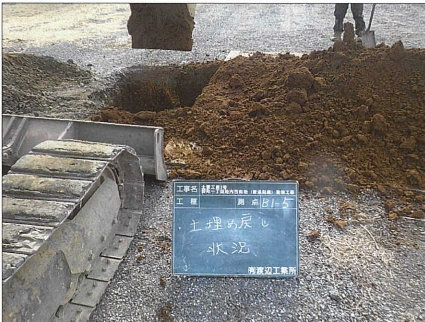
写真区分: 施工状況写真 写真タイトル: 土埋戻し状況 撮影箇所: B1-5
