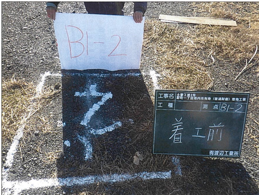
写真区分:着手前及び完成写真 写真タイトル:着工前 撮影箇所:B1-2
