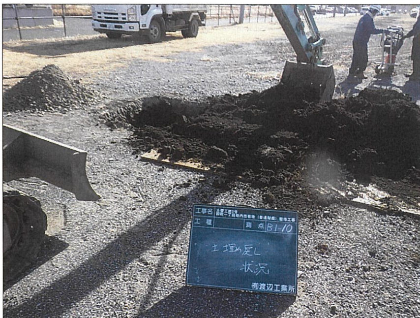
写真区分:施工状況写真 写真タイトル:土埋戻し状況 撮影箇所:B1-10
