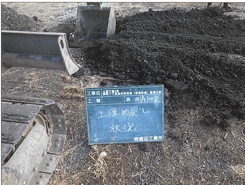
写真区分: 施工状況写真 写真タイトル: 土埋め戻し状況 撮影箇所: A1-2
