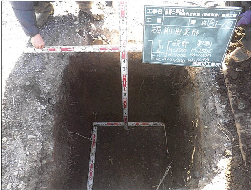
写真区分:出来形管理写真 写真タイトル:掘削出来形 撮影箇所:B1-10 施工管理値:設計H=1500 W1=1000 W2=1000 実測H=1500 W1=1000 W2=1000
