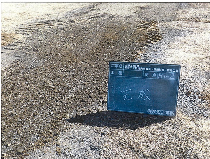
写真区分:着手前及び完成写真 写真タイトル:完成 撮影箇所:B1-2
