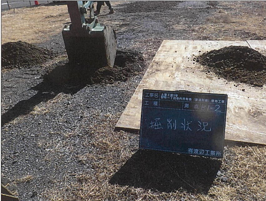
写真区分: 施工状況写真 写真タイトル: 掘削状況 撮影箇所: B1-2
