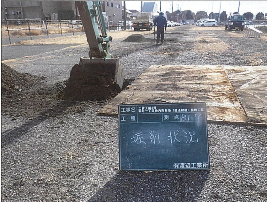
写真区分:施工状況写真 写真タイトル:掘削状況 撮影箇所:B1-7
