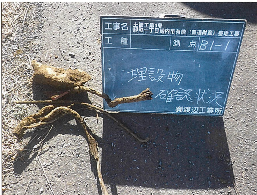
写真区分:施工状況写真 写真タイトル:埋設物確認状況 撮影箇所:B1-1
