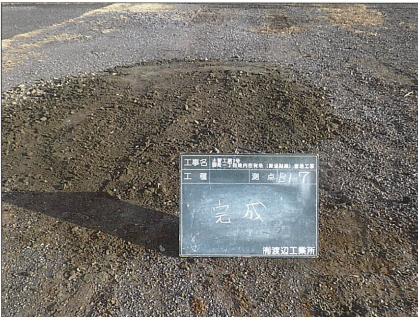
写真区分:着手前及び完成写真 写真タイトル:完成 撮影箇所:B1-7
