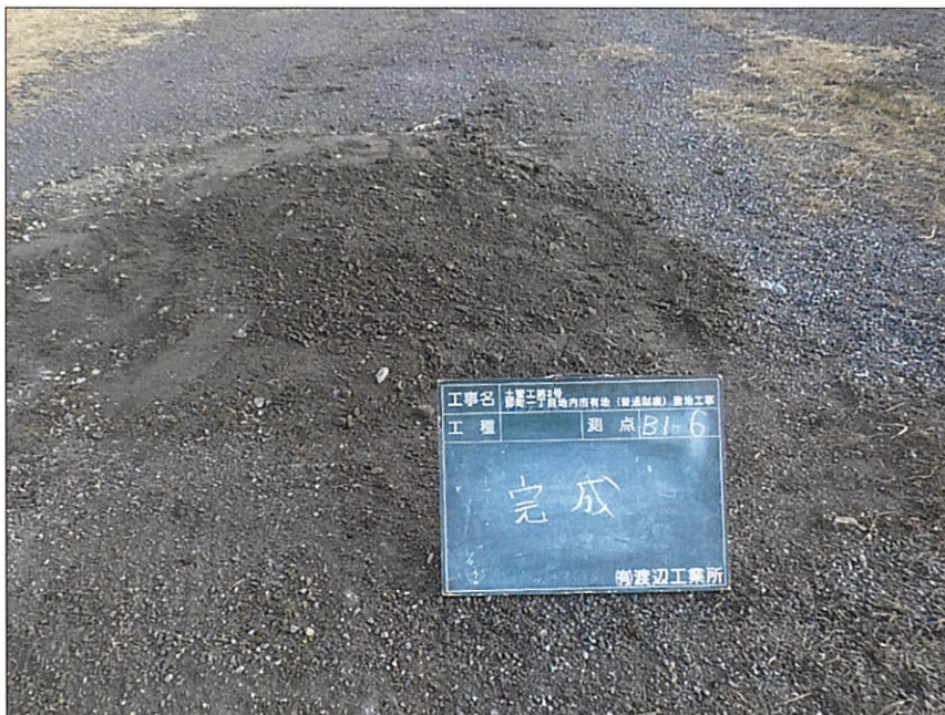
写真区分:着手前及び完成写真 写真タイトル:完成 撮影箇所:B1-6
