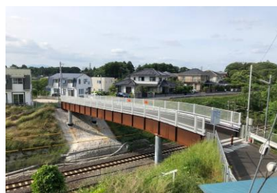
常磐線3号橋（二番橋） （橋梁架替工事）
