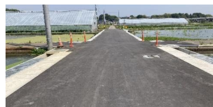
木田余1号雨水幹線整備状況
