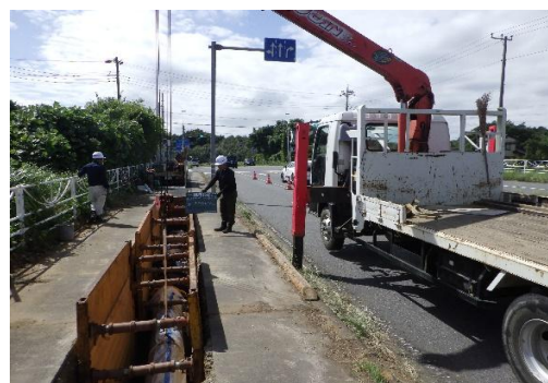
右廻地内送水管布設替工事
