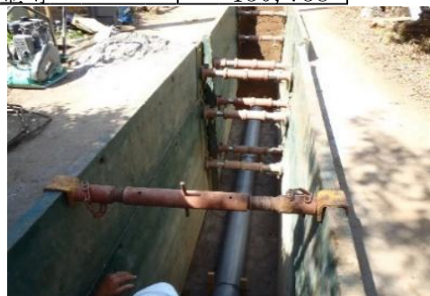
汚水管渠布設工事
