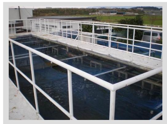
\*バイオモジュール方式:生物担体に多様な微生物を付着させ、汚水中の有機物や浮遊物質を浄化する方法。
