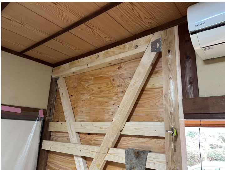
③ 筋交い補強(上部)
