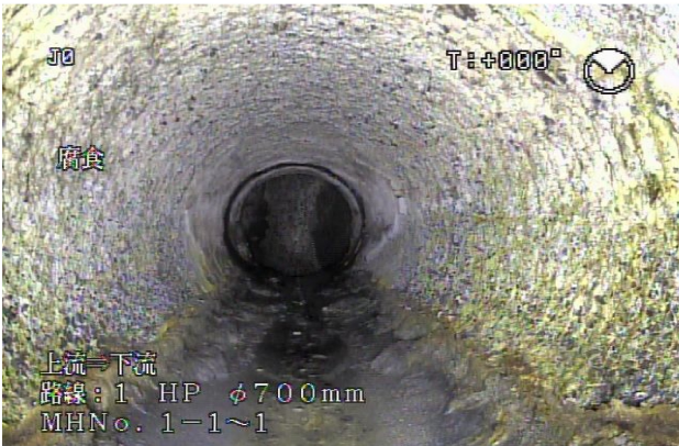
写真4 管路内腐食状況 (豆板状)
