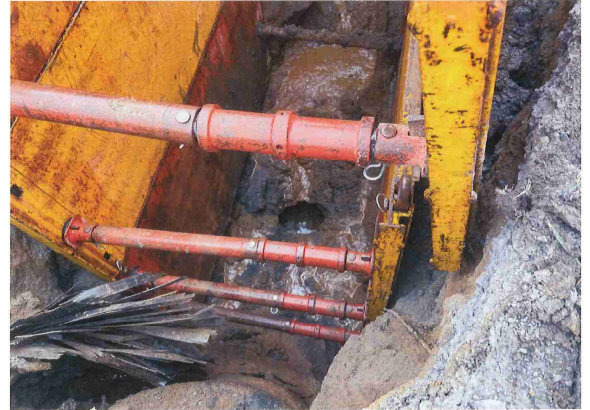
写真2 陥没部（管上部掘削時）
