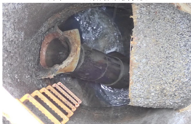
写真 15 内副管破損状況
