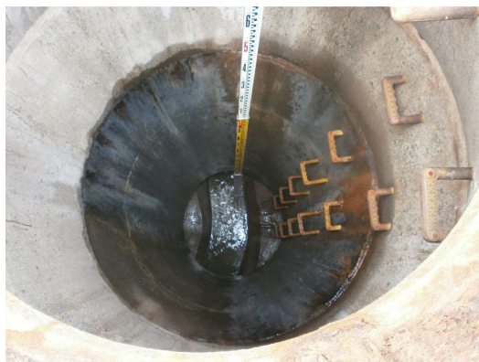
写真 16 浸入水（直壁目地部）
