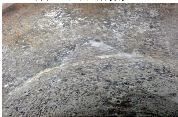
写真 13 人孔内腐食状況
