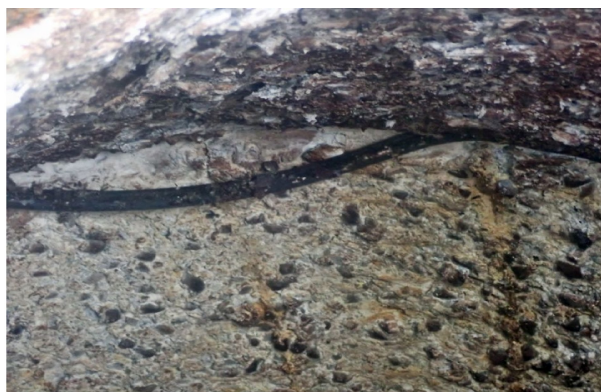
写真11 斜壁目地パッキン不良、人孔腐食
