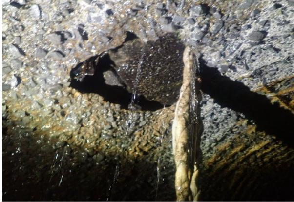
写真1 破損・陥没部（TVカメラ調査工）
