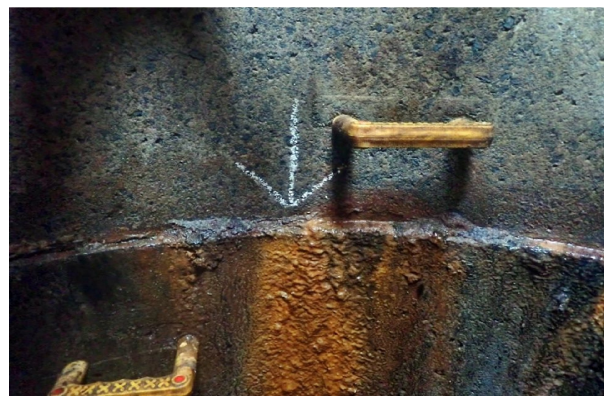
写真 17 直壁目地ズレ（浸入水部）
