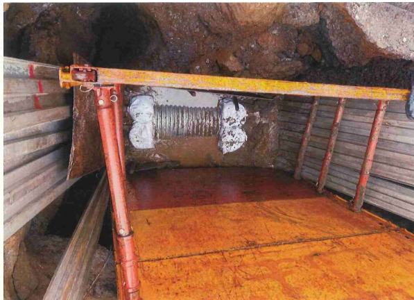
写真3 応急処置状況（コルゲート半割管被せ）
