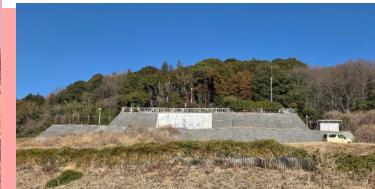
霞ヶ浦からポンプによって送られてきた水を農業用水路に分水する役割があります。分水して残った水は、筑波山の下を掘ったトンネル（水路）を通って南椎尾調整池（桜川市真壁町）に送られます。
