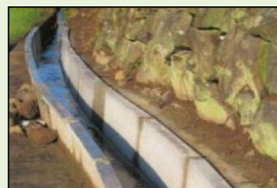
素堀り水路からの更新
