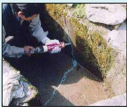
ひび割れの補修
