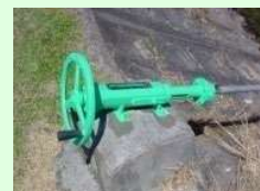
ゲート、バルブの更新
