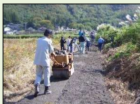
未舗装農道の舗装
