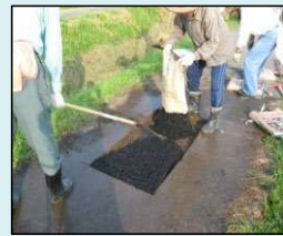
農道の部分補修
