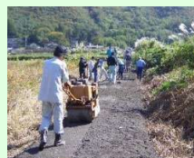
未舗装農道の舗装
