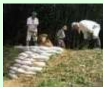
漏水箇所の補修
