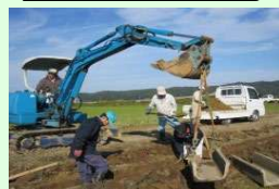
コンクリート水路の更新
