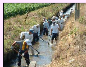
水路の泥上げ
