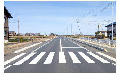
田村沖宿線延伸道路
