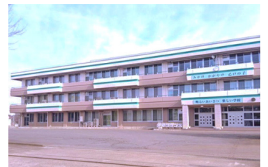
令和7年度 乙戸小学校長寿命化改良工事完成
