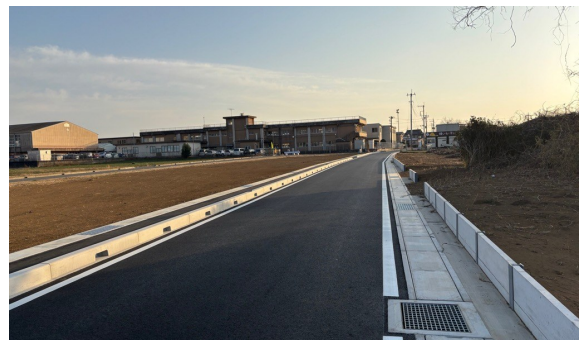
改良工事後の西側道路
