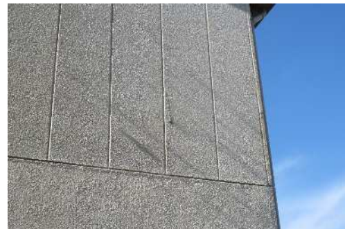
※東側外壁ALC板ひび割れ
