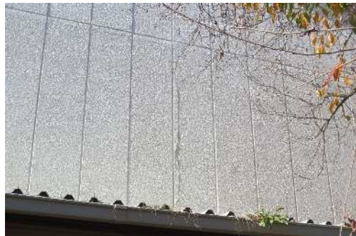
※東側外壁ALC板ひび割れ
