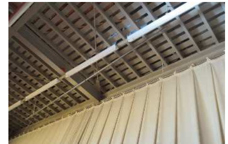
※バック幕及び吊りバトンの状況
