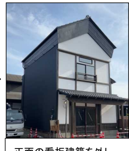
正面の看板建築を外し、元の葺の補修を実施
