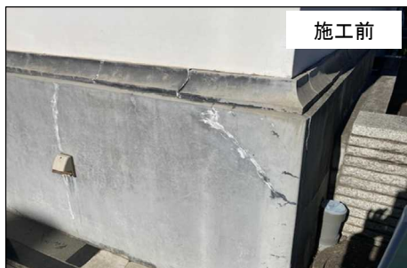
まちかど蔵「大徳」2階通路開口上部壁補修工事
