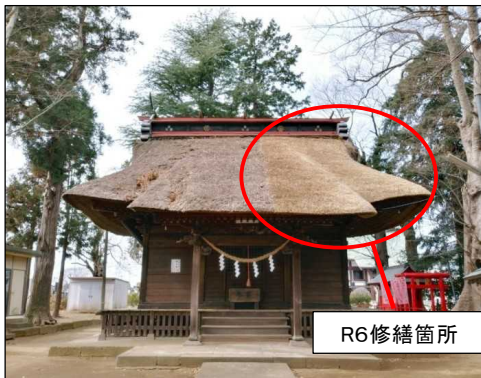
市指定文化財「愛宕神社本拝殿」修繕後の様子
